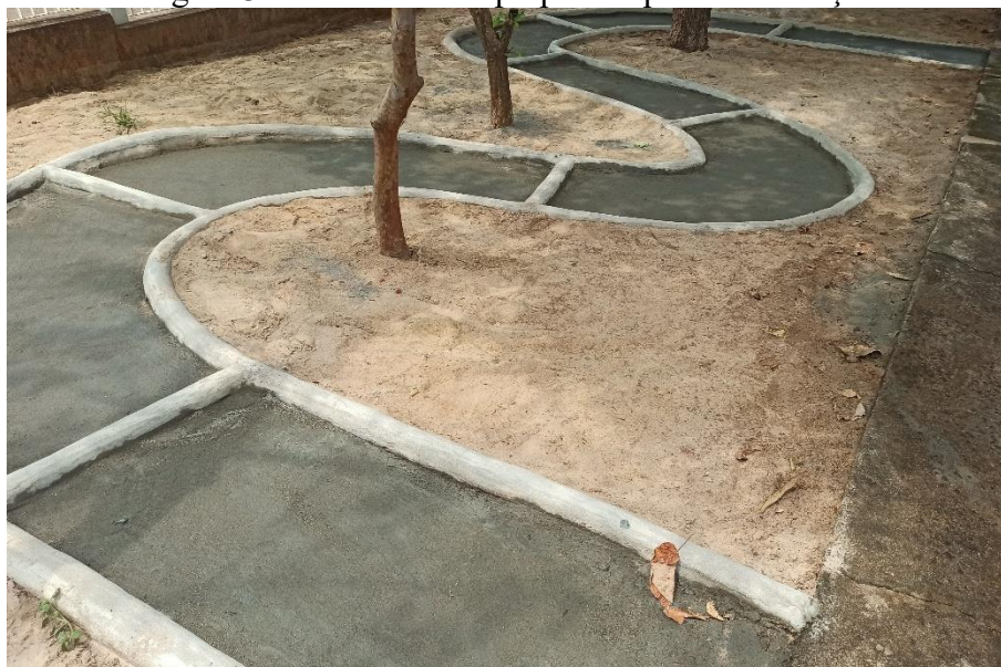
Figura 32 - Trilha sendo preparada para intervenção
