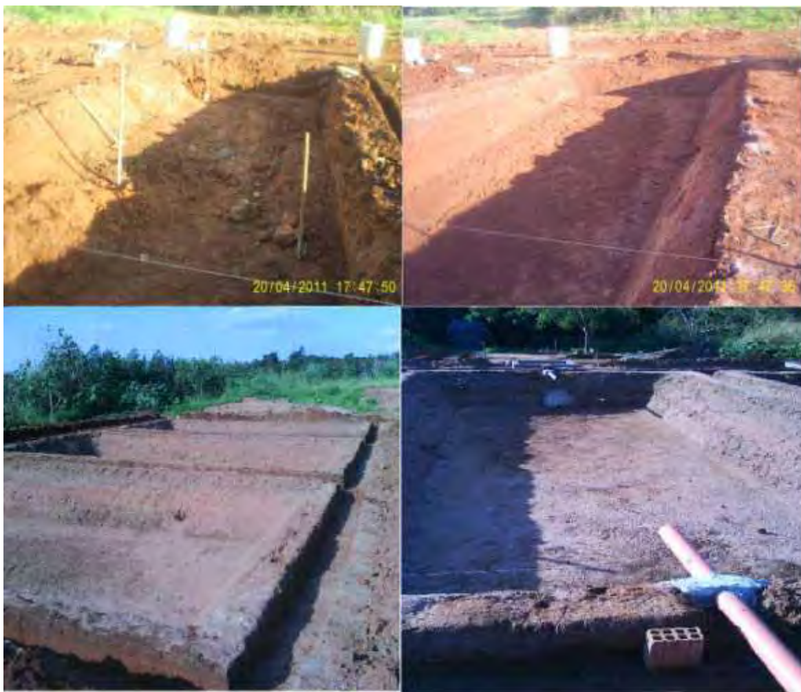
Figura 18 Detalhes da escavação dos leitos.
