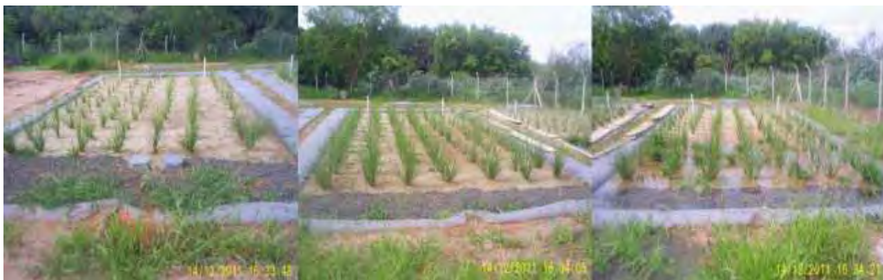
Figura 16 Alagados Construídos de Fluxo Horizontal e escoamento subsuperficial
