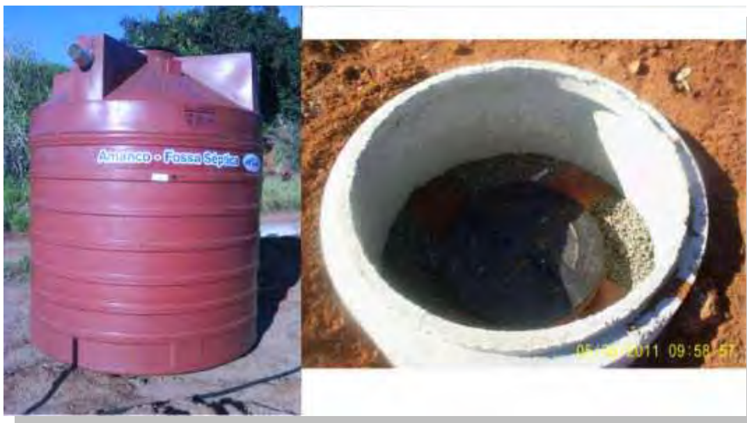
Figura 14 Decantador Primário
