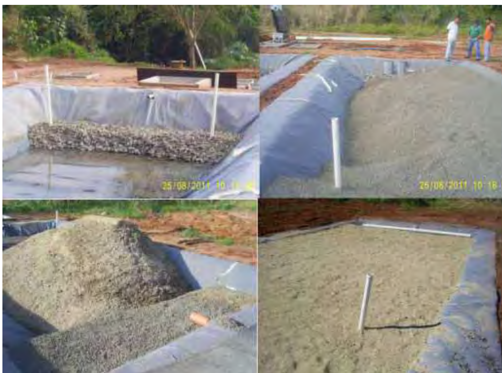
Figura 20 Colocação do material de substrato
