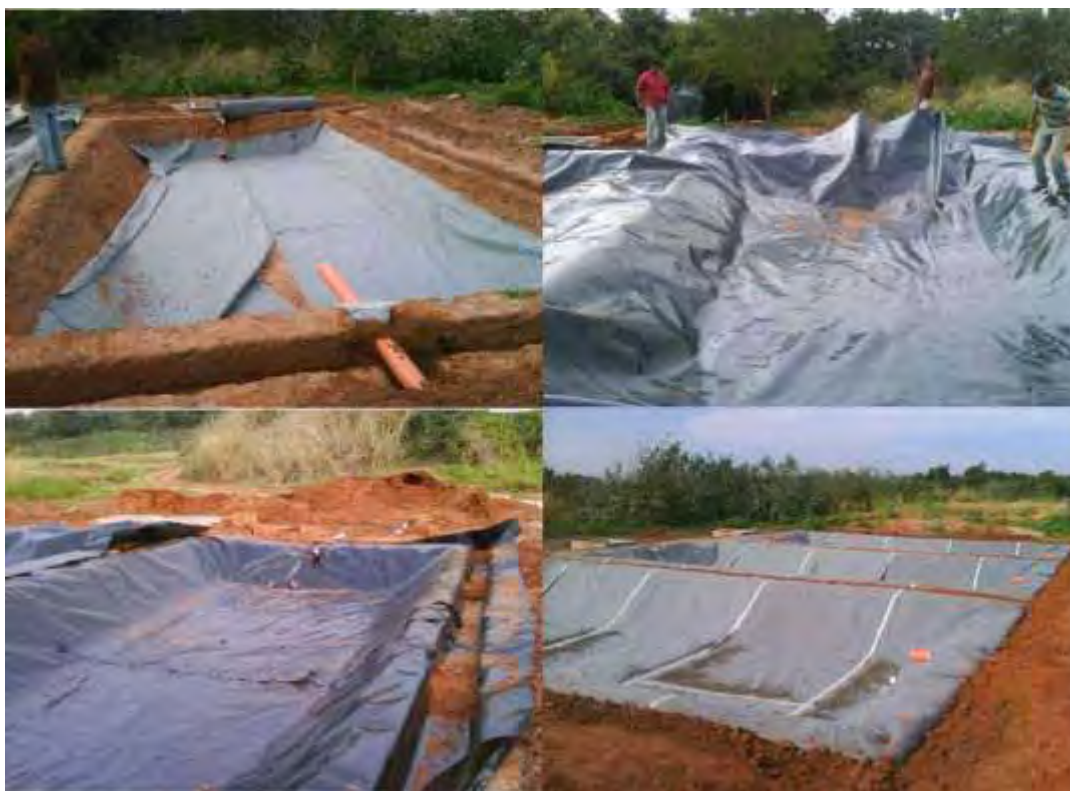
Figura 19 Impermeabilização dos leitos
