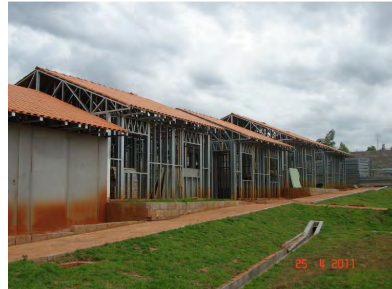
Figura 48 – Montagem das casas da Vila Dignidade em Presidente Prudente/SP
