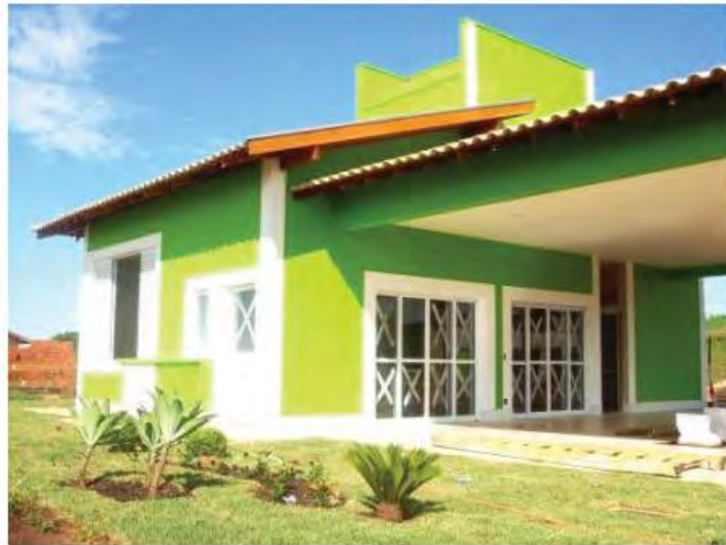
Figura 41 – Vista de uma casa do Condomínio
