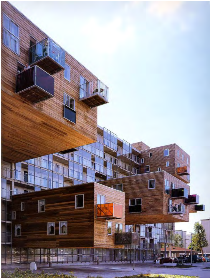
Figura 13 – Fachada Norte de Wozoco.
