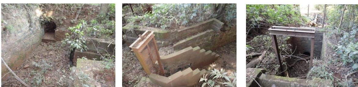
Figura 1.4. Caixa de decantação 2, extravasor e comporta da câmara de Carga
