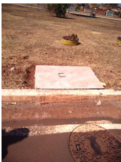
Fotografia 19 - Tampa de bueiro
