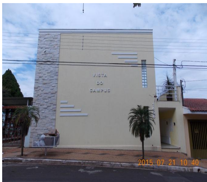
Figura 8: Prédio de Quitinetes no Bairro Bela Vista. Fonte: Quadros, L.S. 2015.
