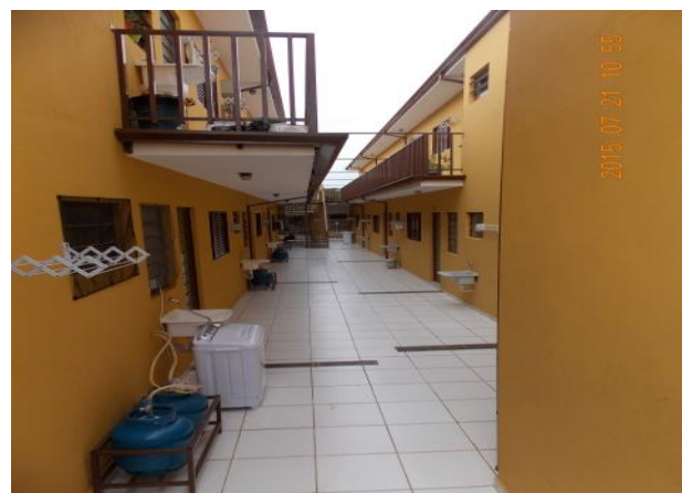
Figura 15: Prédio de Quitinetes no Bairro Bela Vista. Fonte: Quadros,L.S.2015.
