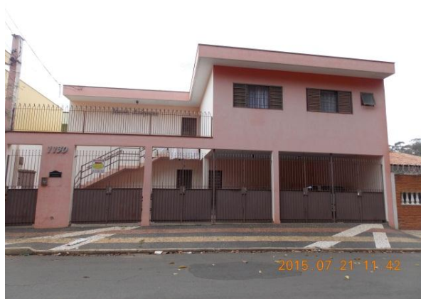
Figura 18: Prédio de Quitinetes no Bairro Bela Vista. Fonte: Quadros, L.S.2015.
