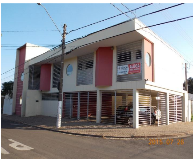
Figura 26: Prédio de Quitinetes no Bairro Vila Indaiá. Fonte: Quadros, L. S. 2015.
