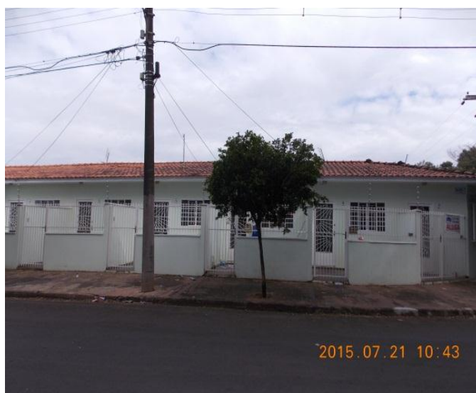
Figura 12: Prédio de Quitinetes no Bairro Bela Vista. Fonte: Quadros, L. S. 2015.
