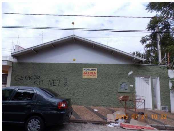
Figura 4: Prédio de Quitinetes no Bairro Bela Vista. Fonte: Quadros, L.S.2015.
