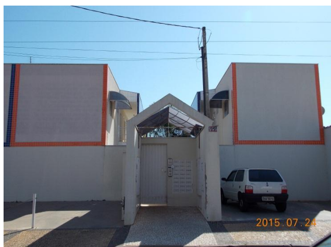
Figura 24: Prédio de Quitinetes no Bairro Vila Indaiá. Fonte: Quadros, L.S.2015.
