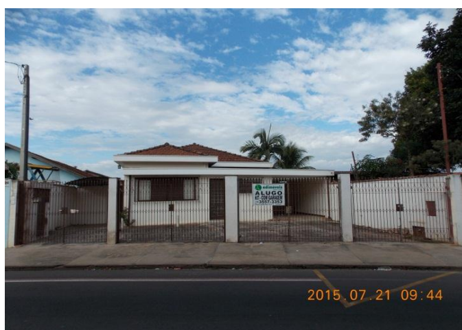
Figura 40: Prédio de Quitinetes no Bairro Vila Indaiá. Fonte: Quadros, L. S. 2015.
