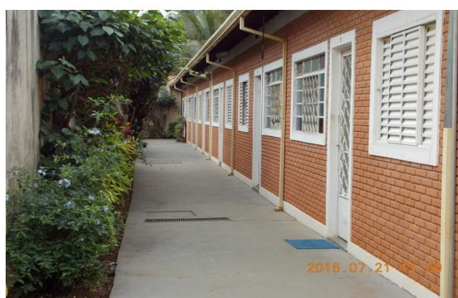
Figura 17: Prédio de Quitinetes no Bairro Bela Vista. Fonte: Quadros,L.S.2015.
