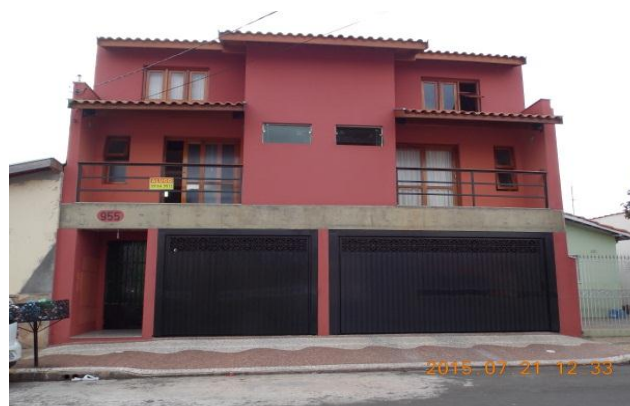
Figura 21: Prédio de Quitinetes no Bairro Bela Vista. Fonte: Quadros, L. S. 2015.
