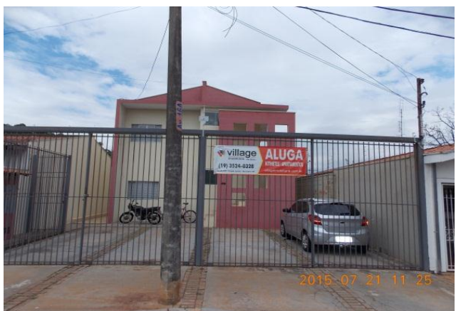
Figura 7: Prédio de Quitinetes no Bairro Bela Vista. Fonte: Quadros, L.S. 2015.
