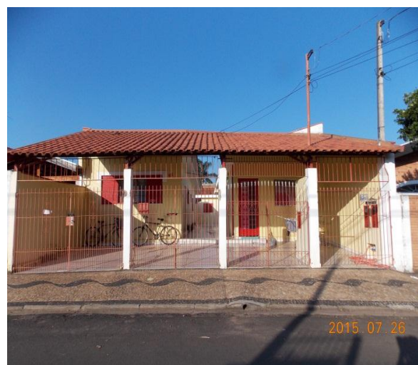
Figura 35: Prédio de Quitinetes no Bairro Vila Indaiá. Fonte: Quadros, L.S.2015.
