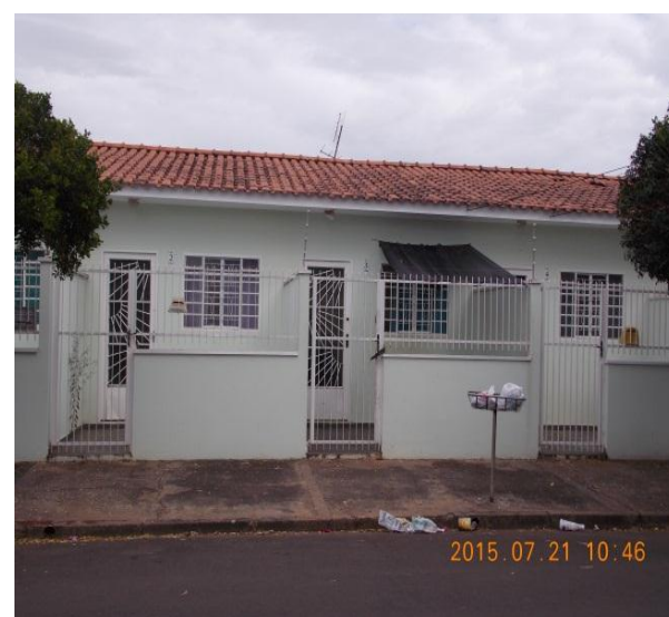
Figura 13: Prédio de Quitinetes no Bairro Bela Vista. Fonte: Quadros, L.S. 2015.
