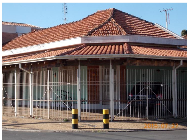
Figura 38: Prédio de Quitinetes no Bairro Vila Indaiá. Fonte: Quadros, L. S. 2015.
