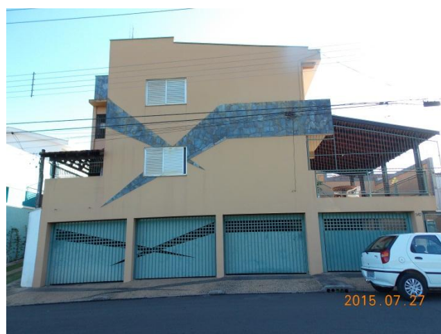
Figura 39: Prédio de Quitinetes no Bairro Vila Indaiá. Fonte: Quadros, L. S. 2015.
