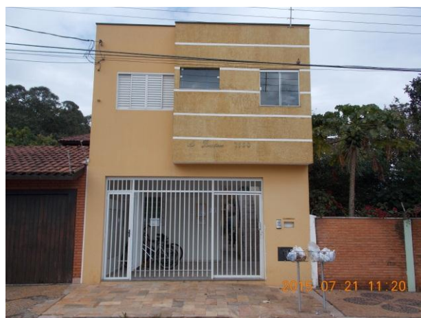
Figura 11: Prédio de Quitinetes no Bairro Bela Vista. Fonte: Quadros, L.S. 2015.
