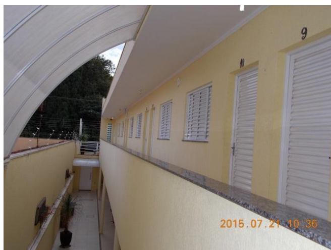
Figura 10: Prédio de Quitinetes no Bairro Bela Vista. Fonte: Quadros, L.S. 2015.
