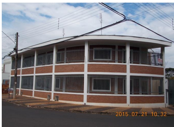
Figura 6: Prédio de Quitinetes no Bairro Bela Vista. Fonte: Quadros, L.S.2015.
