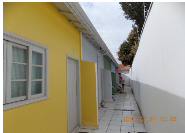
Figura 5: Prédio de Quitinetes no Bairro Bela Vista. Fonte: Quadros, L.S. 2015.
