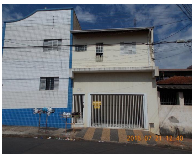
Figura 28: Prédio de Quitinetes no Bairro Vila Indaiá. Fonte: Quadros, L. S. 2015.
