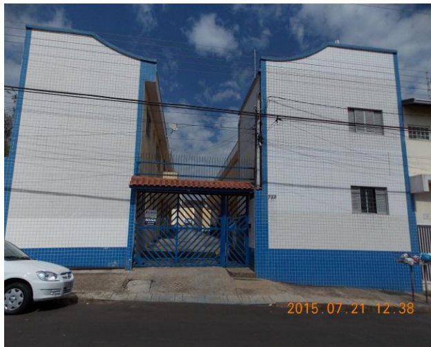
Figura. 22: Prédio de Quitinetes no Bairro Bela Vista . Fonte: Quadros, L. S. 2015.
