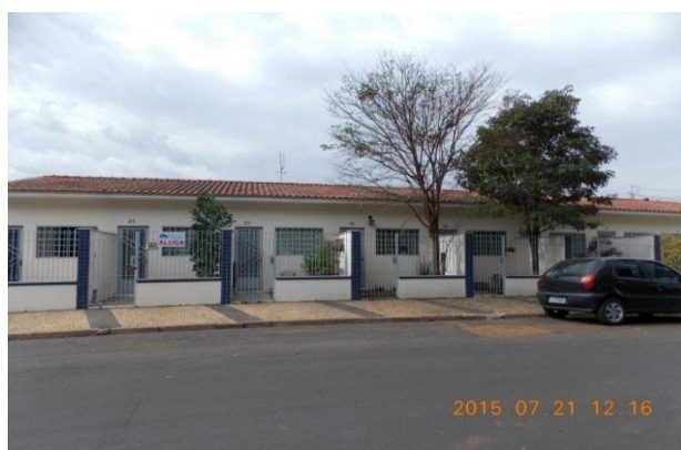
Figura 20: Prédio de Quitinetes no Bairro Bela Vista. Fonte: Quadros, L. S. 2015.
