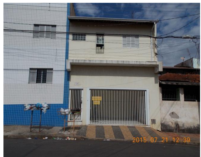
Figura 23: Prédio de Quitinetes no Bairro Bela Vista. Fonte: Quadros, L. S. 2015.
