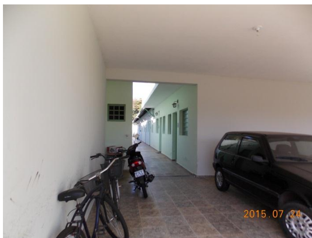
Figura 31: Prédio de Quitinetes no Bairro Vila Indaiá. Fonte: Quadros, L.S.2015.
