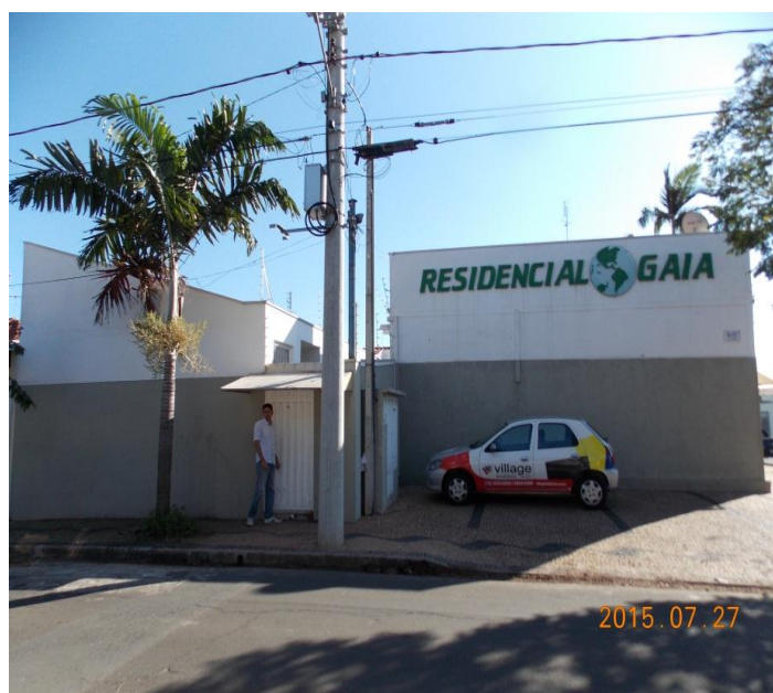
Figura 36: Prédio de Quitinetes no Bairro Vila Indaiá. Fonte: Quadros, L. S. 2015.
