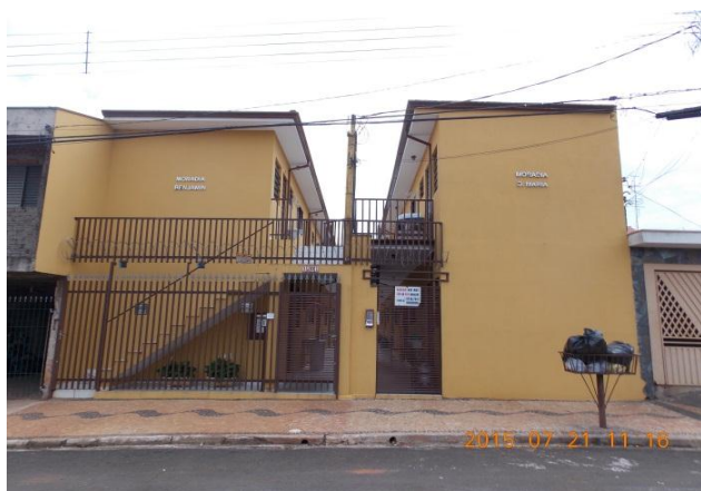
Figura 14: Prédio de Quitinetes no Bairro Bela Vista. Fonte: Quadros,L.S.2015.
