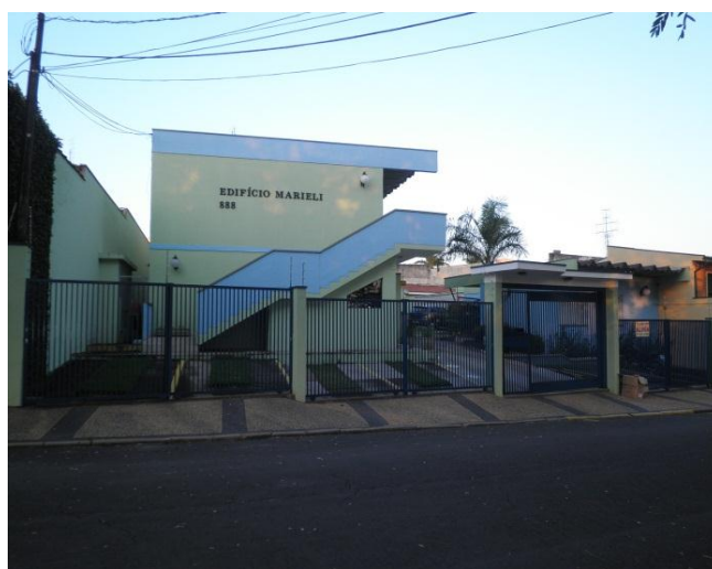
Figura 27: Prédio de Quitinetes no Bairro Vila Indaiá. Fonte: Quadros, L.S.2015.
