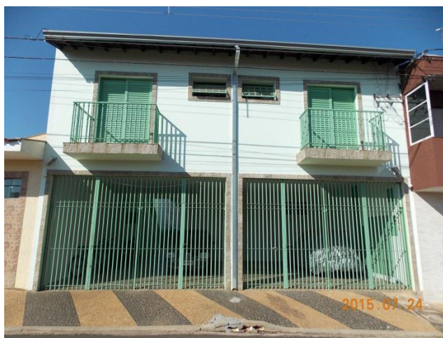
Figura 30: Prédio de Quitinetes no Bairro Vila Indaiá. Fonte: Quadros, L.S.2015.
