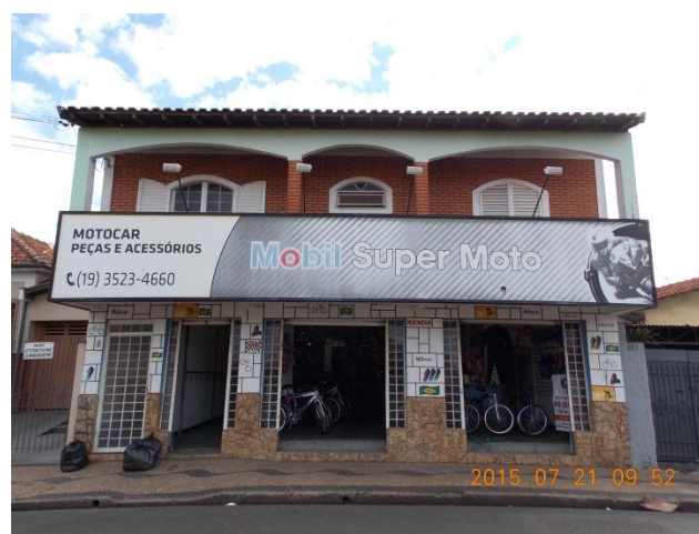
Figura 41: Prédio de Quitinetes no Bairro Vila Indaiá. Fonte: Quadros, L. S. 2015.
