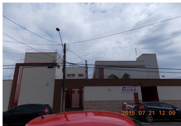
Figura 19: Prédio de Quitinetes no Bairro Bela Vista. Fonte: Quadros, L. S. 2015.
