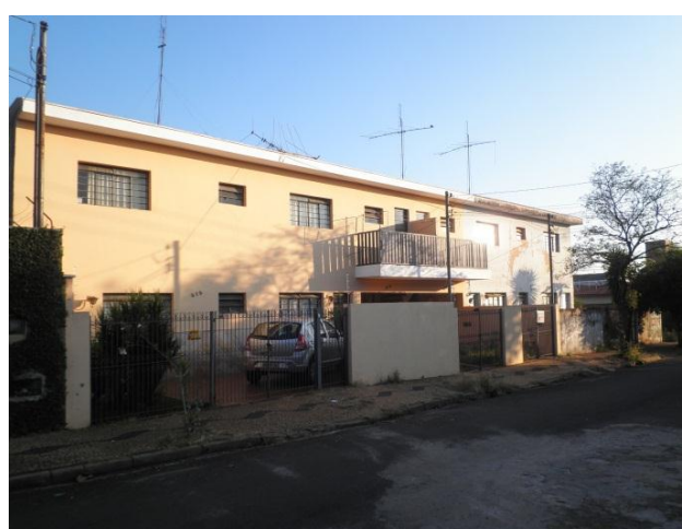
Figura 33: Prédio de Quitinetes no Bairro Vila Indaiá. Fonte: Quadros, L. S. 2015.
