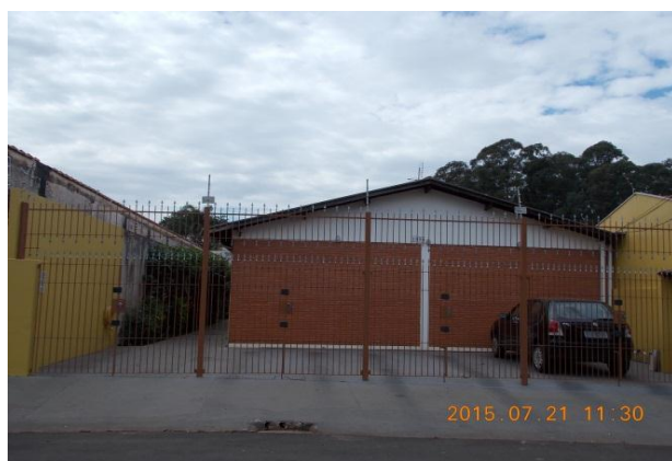
Figura 16: Prédio de Quitinetes no Bairro Bela Vista. Fonte: Quadros,L.S.2015.
