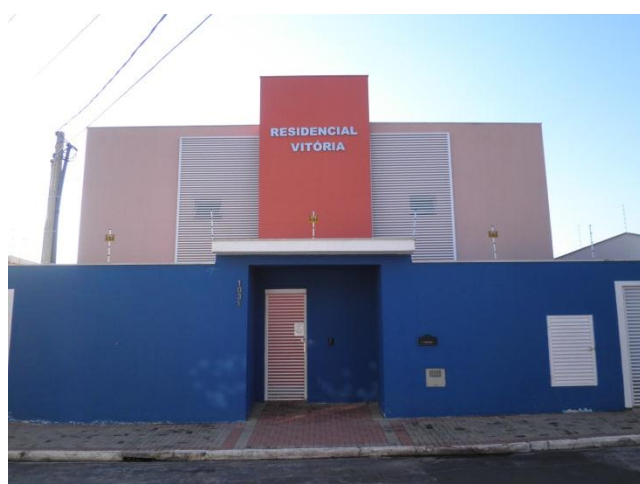
Figura 32: Prédio de Quitinetes no Bairro Vila Indaiá. Fonte: Quadros, L. S. 2015.
