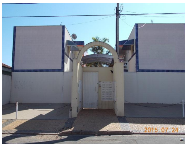
Figura 25: Prédio de Quitinetes no Bairro Vila Indaiá. Fonte: Quadros, L. S. 2015.
