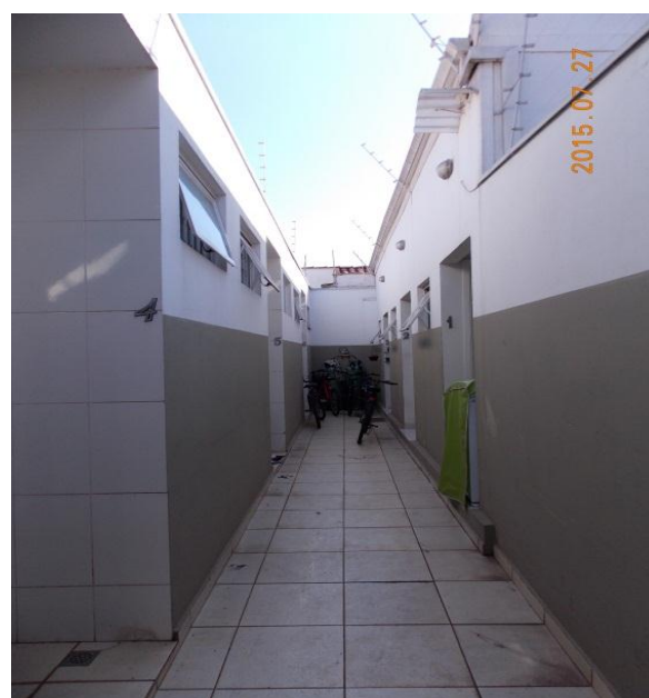
Figura 37: Prédio de Quitinetes no Bairro Vila Indaiá. Fonte: Quadros, L.S.2015.
