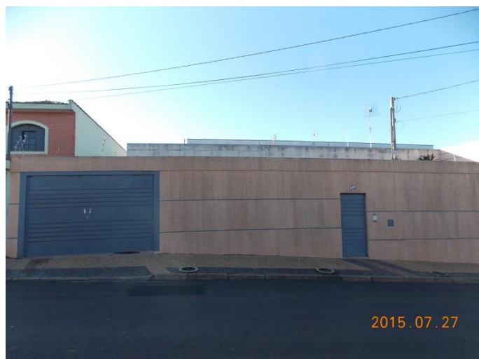
Figura 34: Prédio de Quitinetes no Bairro Vila Indaiá. Fonte: Quadros, L. S. 2015.
