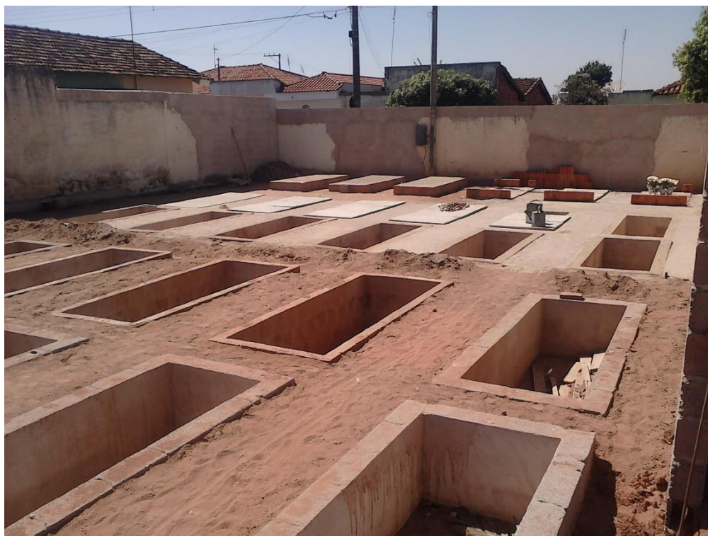
Foto 02: Área nova do cemitério sendo construída.
