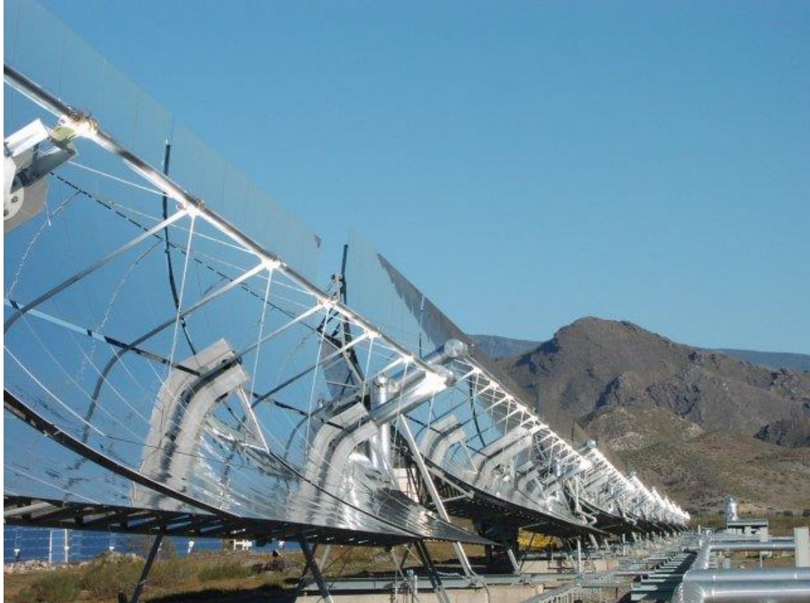
Figura 6 – Concentrador Cilindro Parabólico (PTC)
