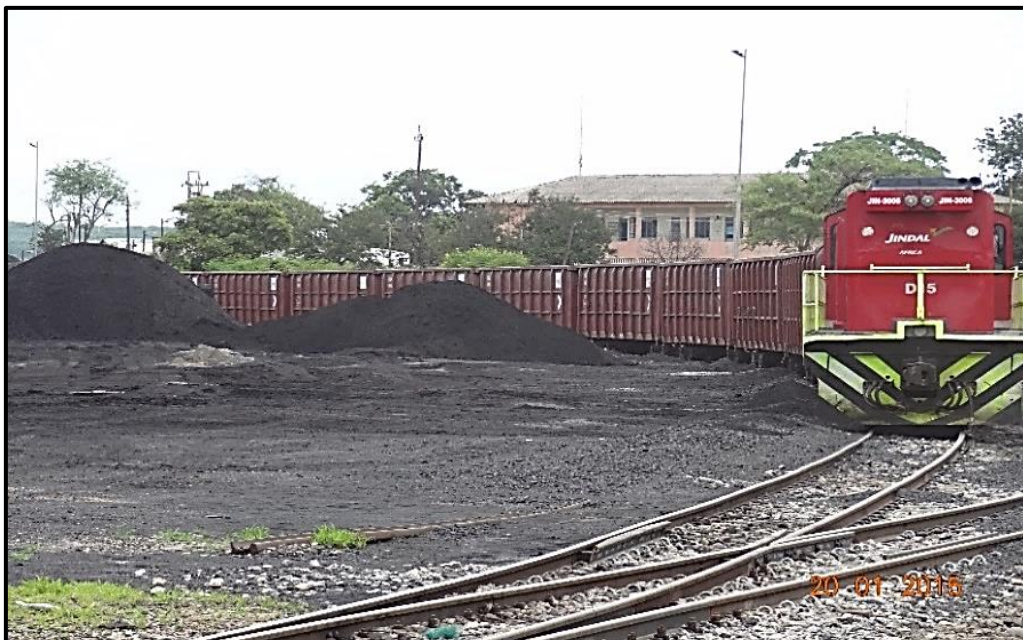
Fotografia 41 – Vista parcial da ferrovia que atravessa o Bairro 1º. de Maio, em Moatize.
