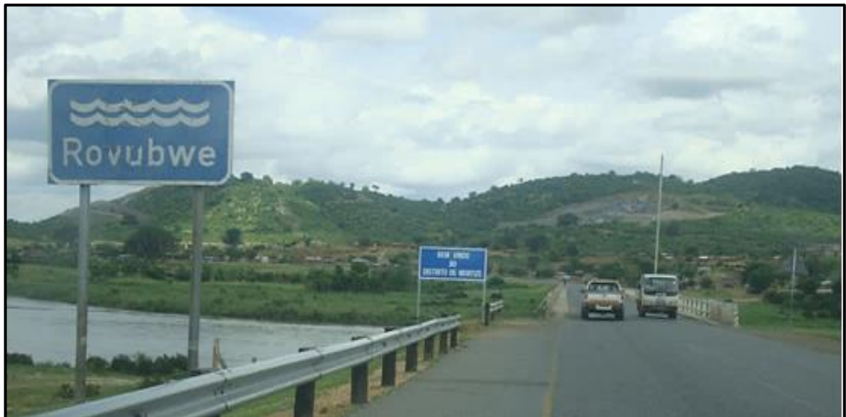
Fotografia 7 - Rio Rovúbwè – vista da margem direita, no trecho da ponte que lida cidade de Tete e distrito de Moatize
