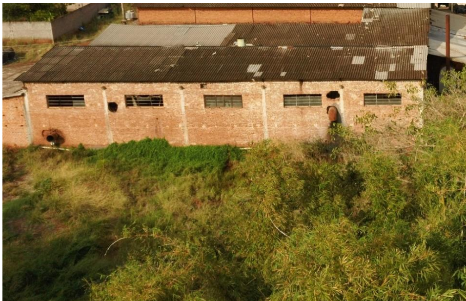
Figura – 14 – Canos de descarte de água de curtume despejado diretamente sobre a margem do córrego
