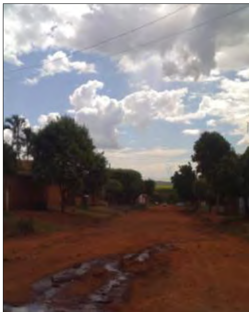
Figura 12: Bairros em construção e sem pavimentação.
