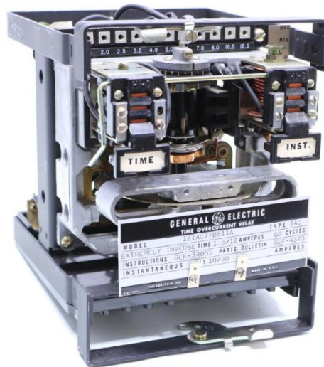
Figura 1 – Relé eletromecânico
