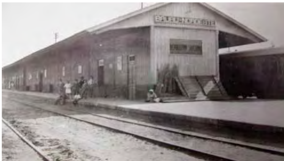
Figura 15 – Estação da EFNOB . PELEGRINA, G. R. Acervo fotográfico pessoal. O autor desta fotografia captou um ângulo controvertido deixando dúvidas, até pouco tempo atrás, sobre a estação de a EFNOB ter sido construída em madeira ou não.
