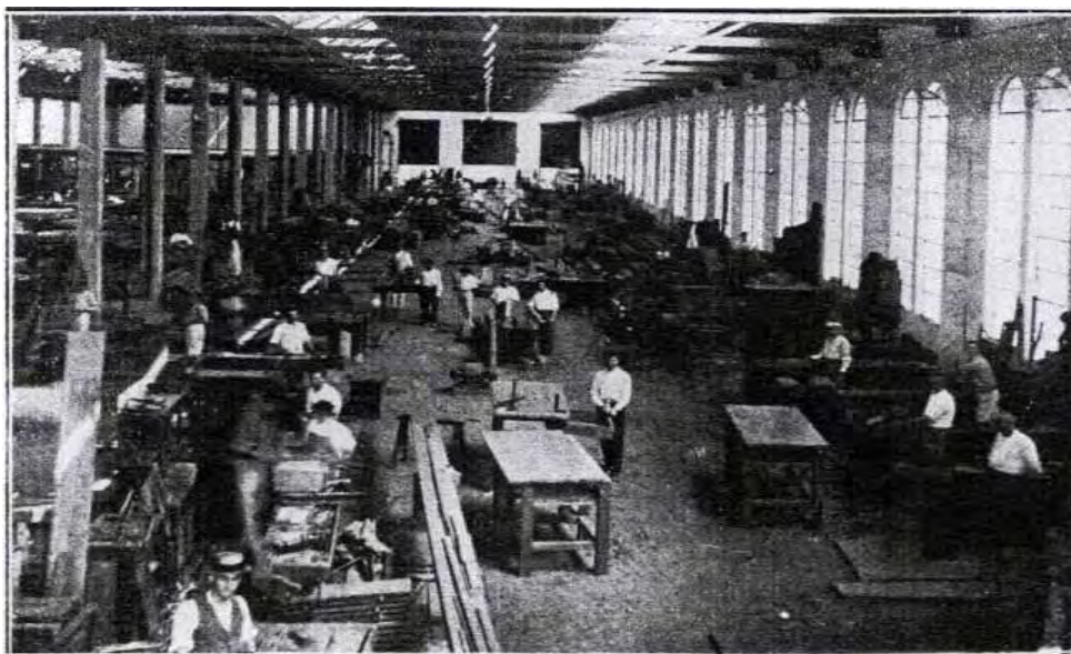
Figura 06 – Vista interna das novas oficinas, seção de carpintaria e marcenaria. ESTRADA DE FERRO NOROESTE DO BRASIL Relatório da Diretoria referente ao exercício de 1921 . Anexo fotográfico.
