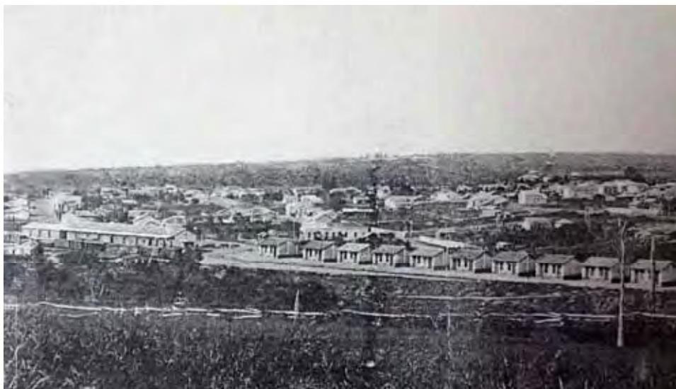
Figura 17 – Estação da Cia. Paulista de Estrada de Ferro , 1910. PELEGRINA, G. R. Acervo fotográfico pessoal. Vêm-se as casas da Vila Ferroviária ao lado direito da Estação.
