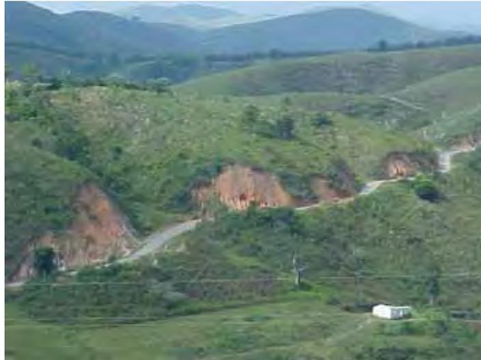
Figura 19 - Áreas com processo erosivo evidente.
