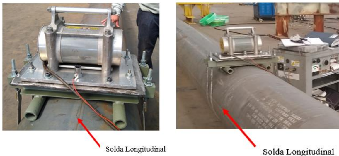
a) Indutor à 0° sobre a solda
