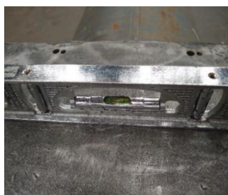
c) Nivelamento transversal à solda. (paralelo)
