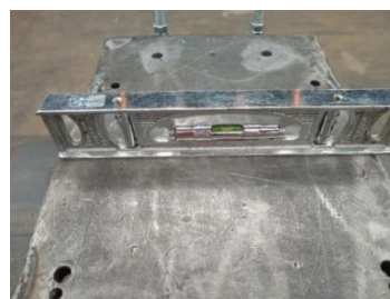
d) Nivelamento longitudinal à solda.
