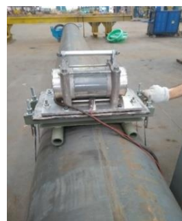
f) Montagem do indutor e acelerômetro
