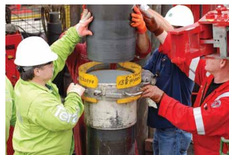
b) Montagem de Tubos de revestimento
