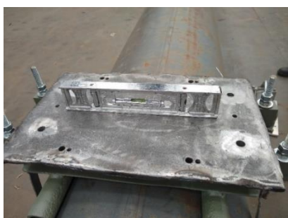
e) Dispositivo fixado e alinhado.
