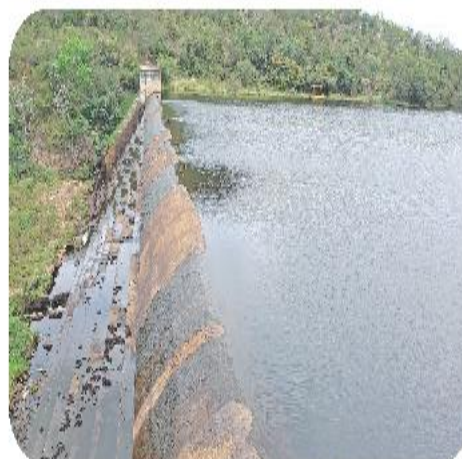
Barragem do distrito Cachoeira Grande
