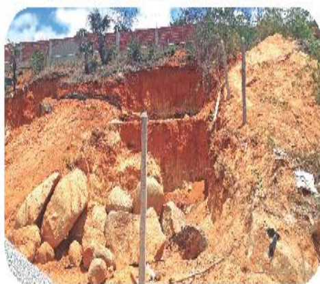
Área com cortes em talude e retirada de blocos rochosos
