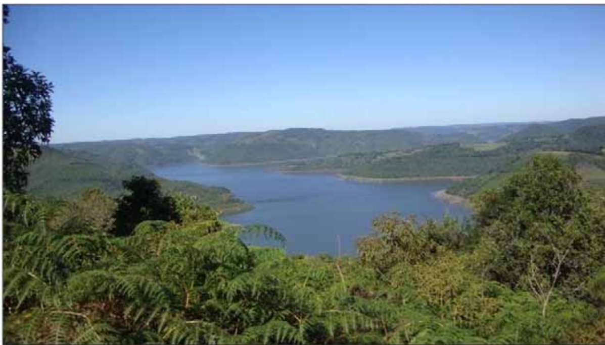
Figura 12: Vista do lago da UHE Barra Grande no trecho de divisa entre os municípios de Pinhal da Serra/RS e Anita Garibaldi/SC.
