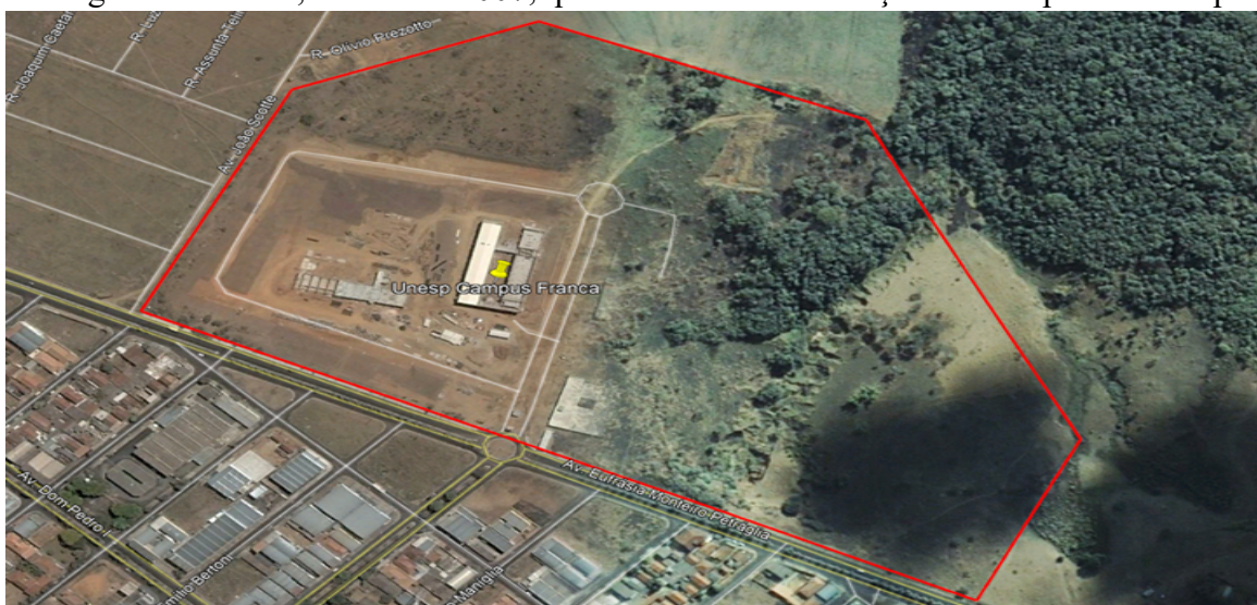
Imagem 01. Imagem de satélite da área da Unesp delimitada em vermelho, em fase de construção do Campus, no ano de 2007. Fonte: Google Earth, 2007.
