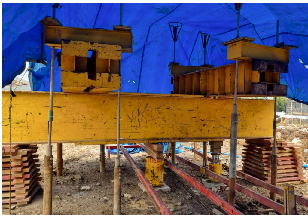
Figura 3.4 - Execução de prova de carga estática com helicoides.
