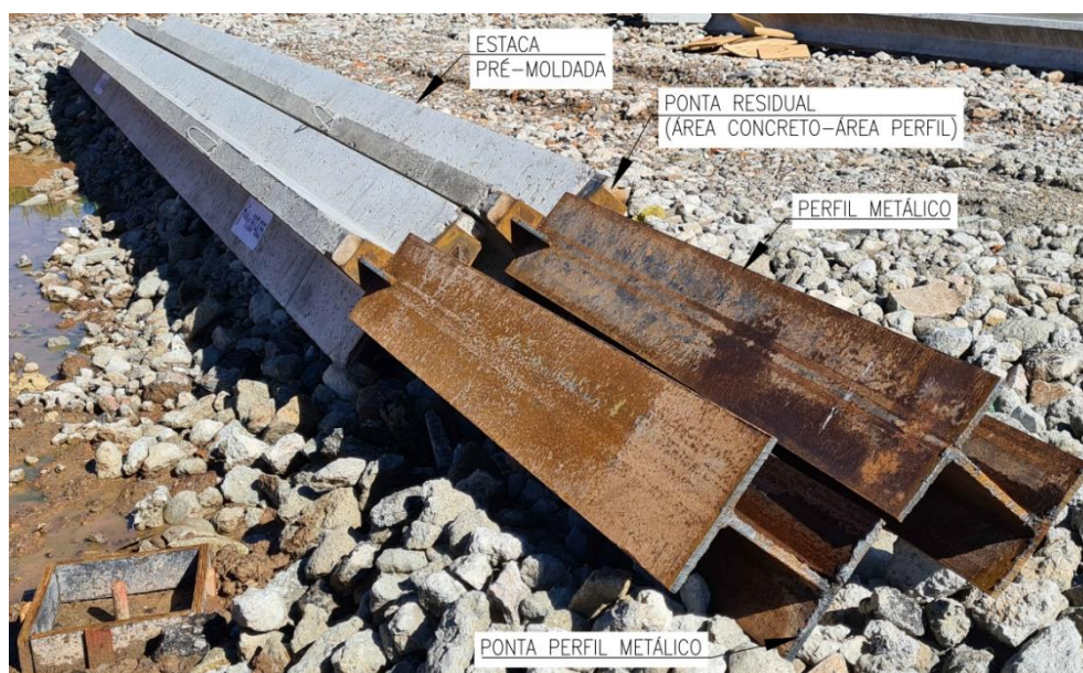
Figura 4.12 - Considerações para a resistência de ponta da solução em estaca mista.
