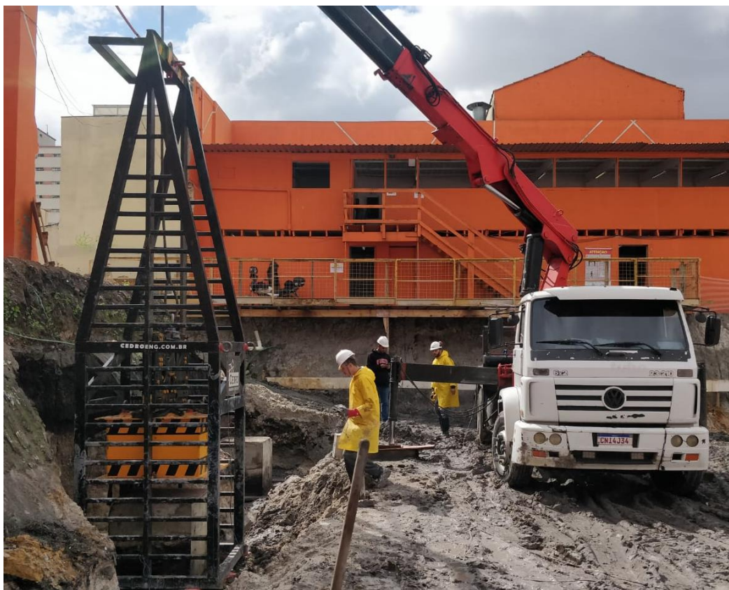
Figura 3.5 - Caminhão “munck” como alternativa ao bate-estaca convencional.
