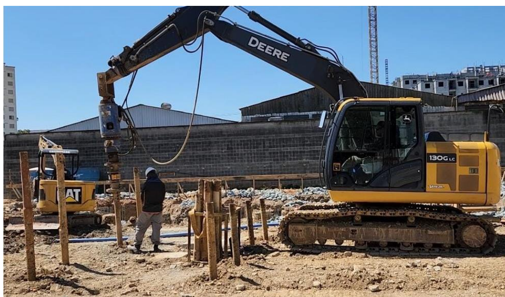
Figura 3.3 - Instalação de helicoides no solo.
