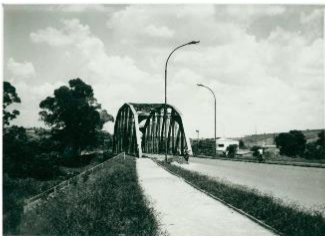
Figura 3: Ponte de Ferro.
