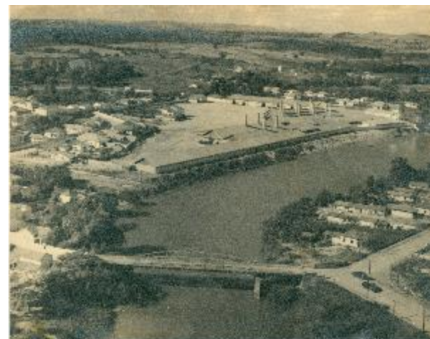
Figura 4: Cerâmica Mogi Guaçu ao fundo.
