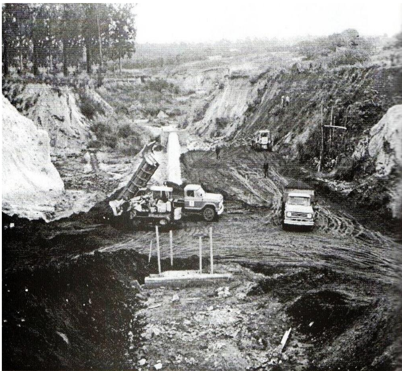
Obras para contenção do “Buracão da Vila Operária” - Década de 70
