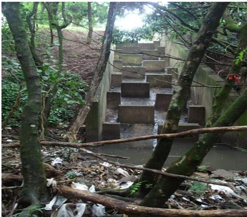
Figura 33 – Imagem frontal do dissipador de energia. Fonte: fotos da autora.
