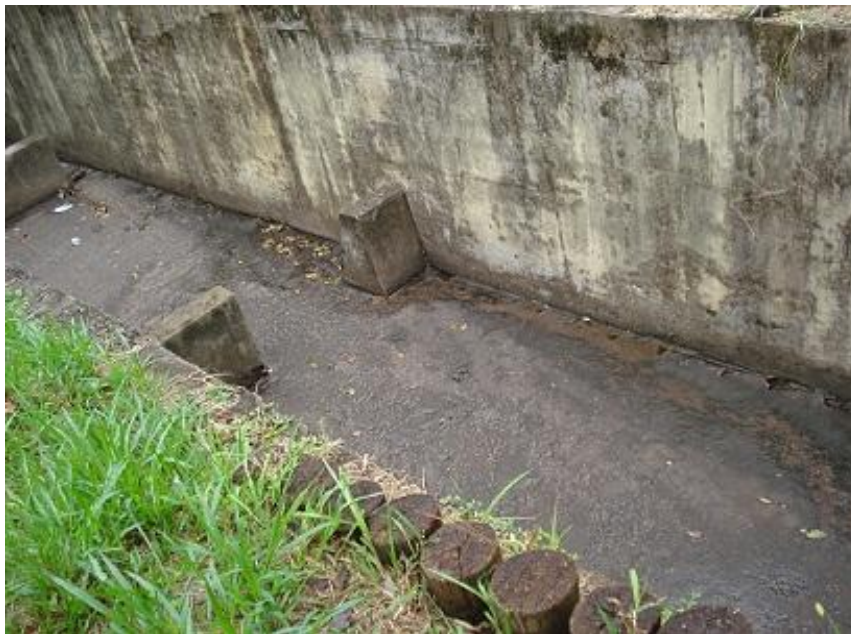
Figura 28 – Escoadouro e dissipadores de energia. Vista do outro lado da ponte citada na figura 27.
