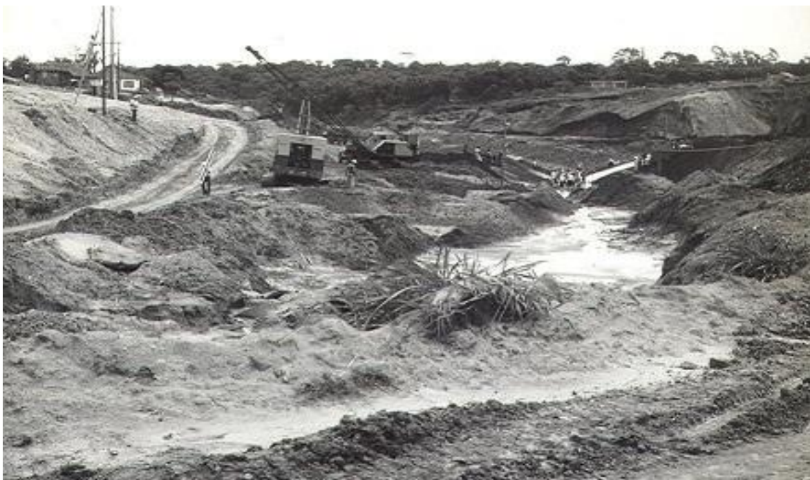
Figura 43 – Obras para tentativa de contenção de erosão no Parque Buracão, na área central da foto é possível notar um pequeno reservatório de água, trata-se da nascente em questão.
