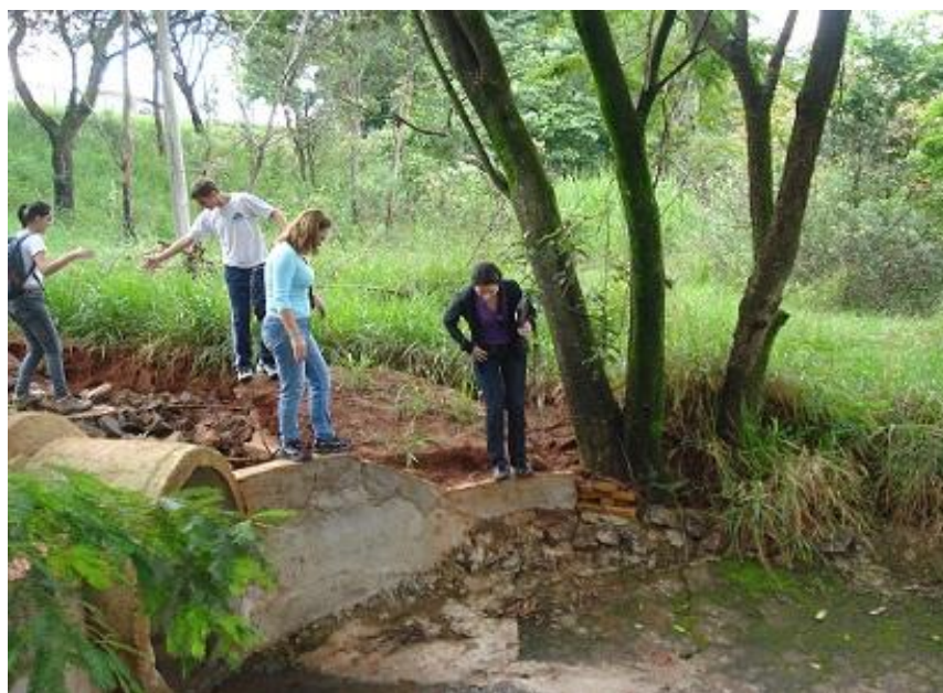
Figura 38 – Descida pelo escoadouro no ponto mais distante da nascente principal. Observar o diâmetro da galeria de drenagem. Fonte: fotos da autora.
