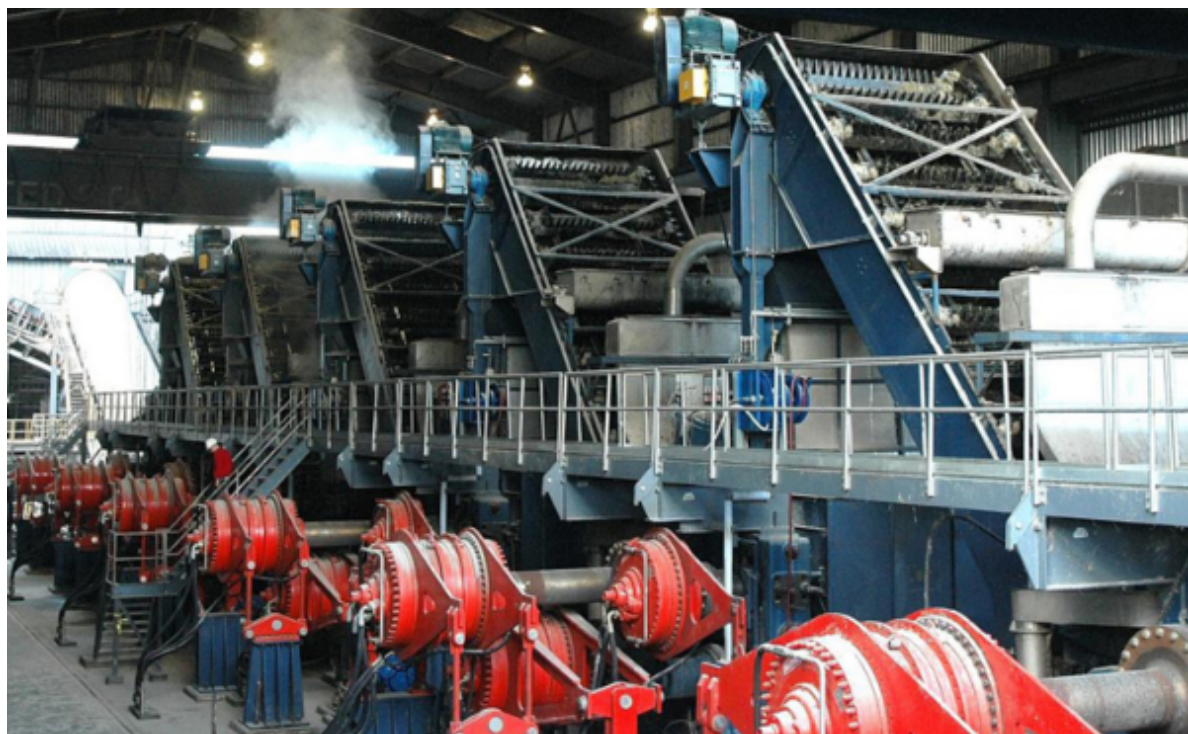
Figura 34 – Tandén de Moenda da linha MCD/01, com acionamento eletro-hidráulico.
