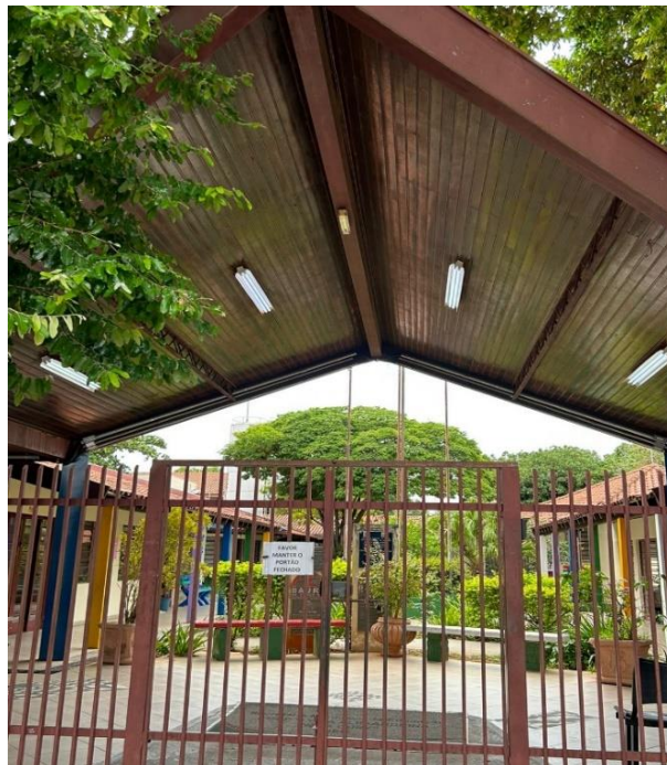
Figura 4 - Entrada da Escola Municipal de Ensino Fundamental Núcleo de Ensino Renovado “Lydia Alexandrina Nava Cury”.
