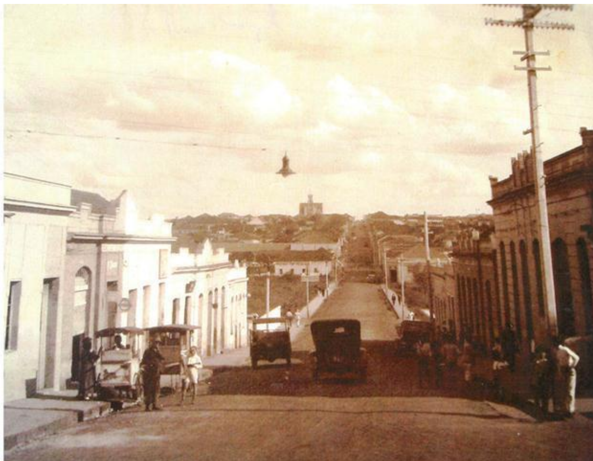
Figura 78 – Fotografia retirada a partir da Estação Ferroviária com frente para a Rua Rio de Janeiro de 1925.
