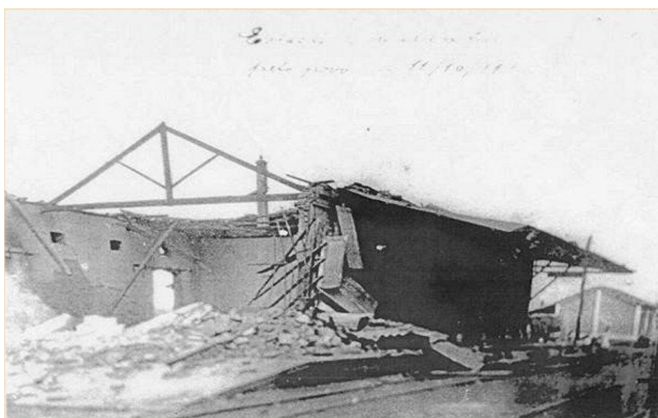
Figura 62 – Incêndio na primeira Estação Ferroviária.
