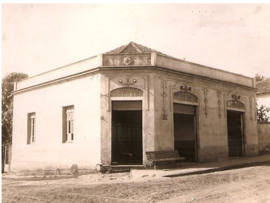
Figura 81 – Prédio da Companhia Nacional de Energia Elétrica de Catanduva, em 1940.
