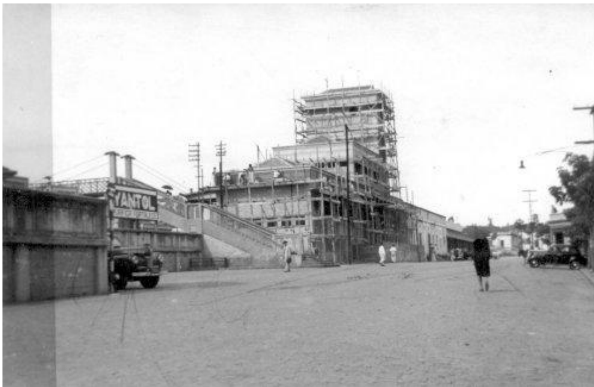
Figura 64 – Reforma da segunda Estação Ferroviária entre os anos de 1930 a 1945.
