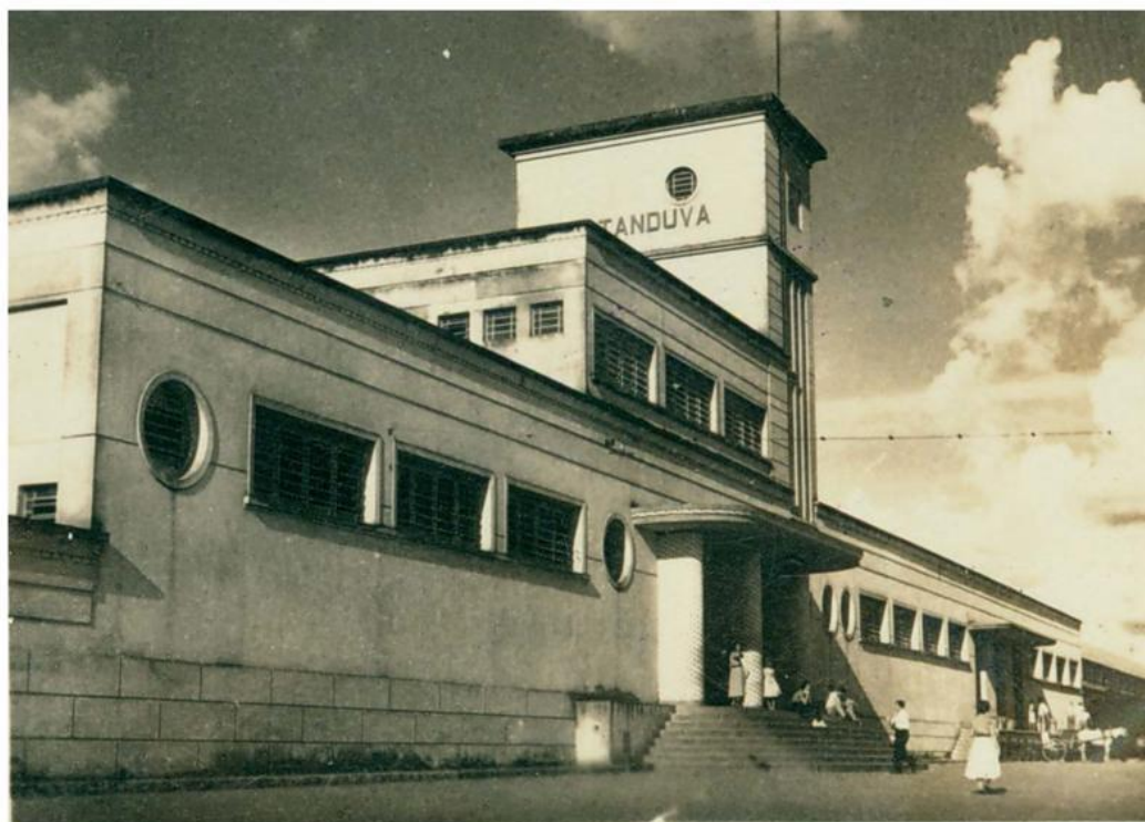
Figura 65 – Estação Ferroviária pós-reforma.
