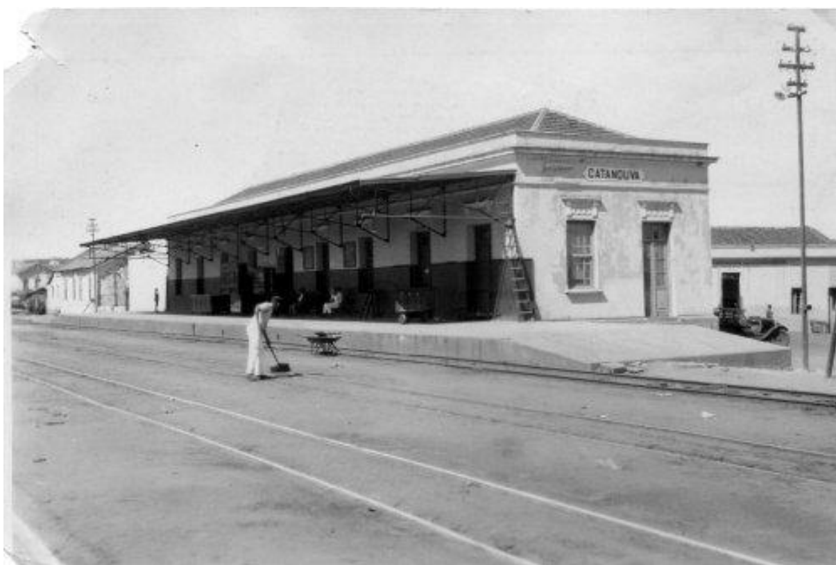
Figura 63 – Construção da segunda Estação Ferroviária em 1920.
