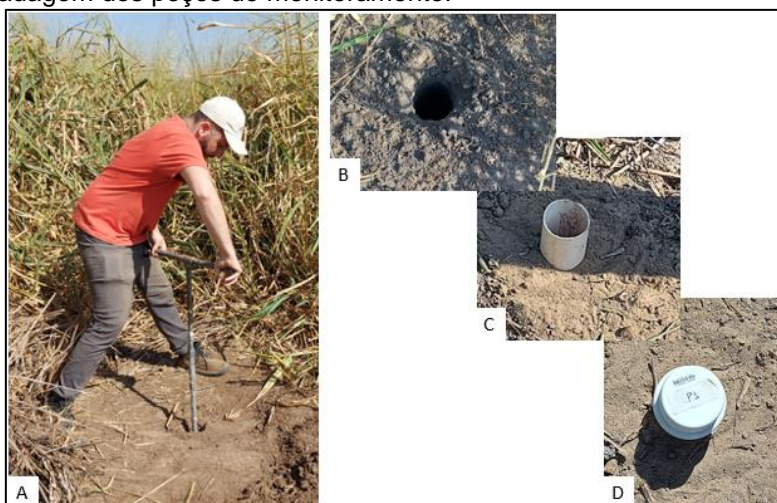
Figura 30 – Tradagem dos poços de monitoramento.
