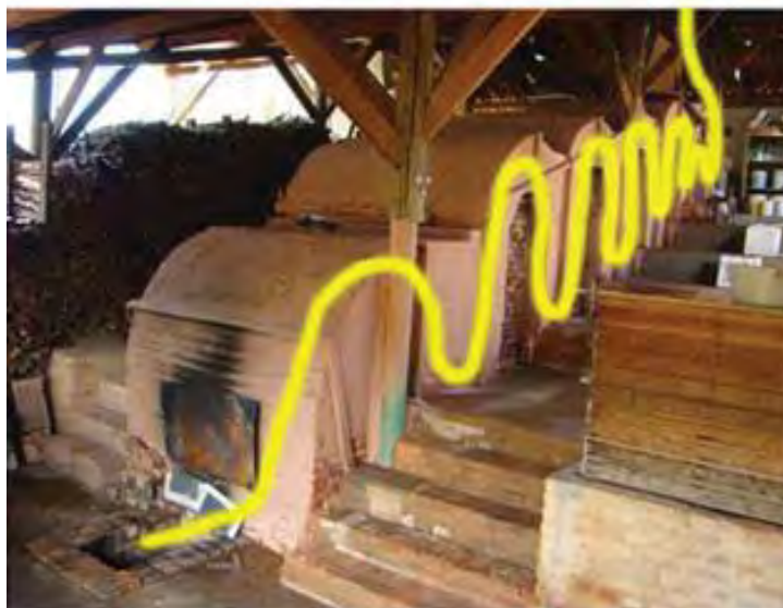
Figura 53, 54 e 55: ACIMA: O forno Noborigama; AO CENTRO: suas partes, vermelho: fornalha, azul: câmaras, verde: chaminé. ABAIXO: caminho percorrido pelo calor.
