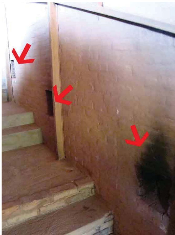
Figura 58: Aberturas para alimentação lateral do forno Noborigama do Ateliê Oficina da Cerâmica.
