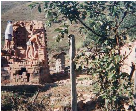
Figura 37: Desmontando uma caieira, 2000.
