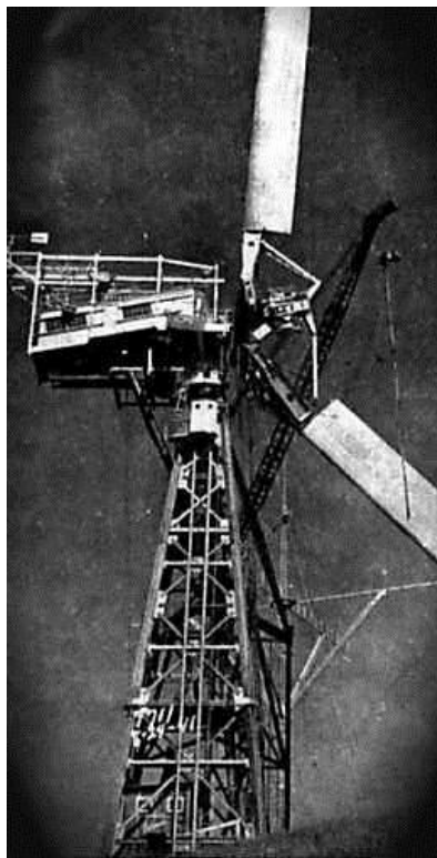
Figura 6 – Aerogerador Smith-Putnam, com geração da ordem de grandeza de MW (Fonte: Dutra, 2001).
