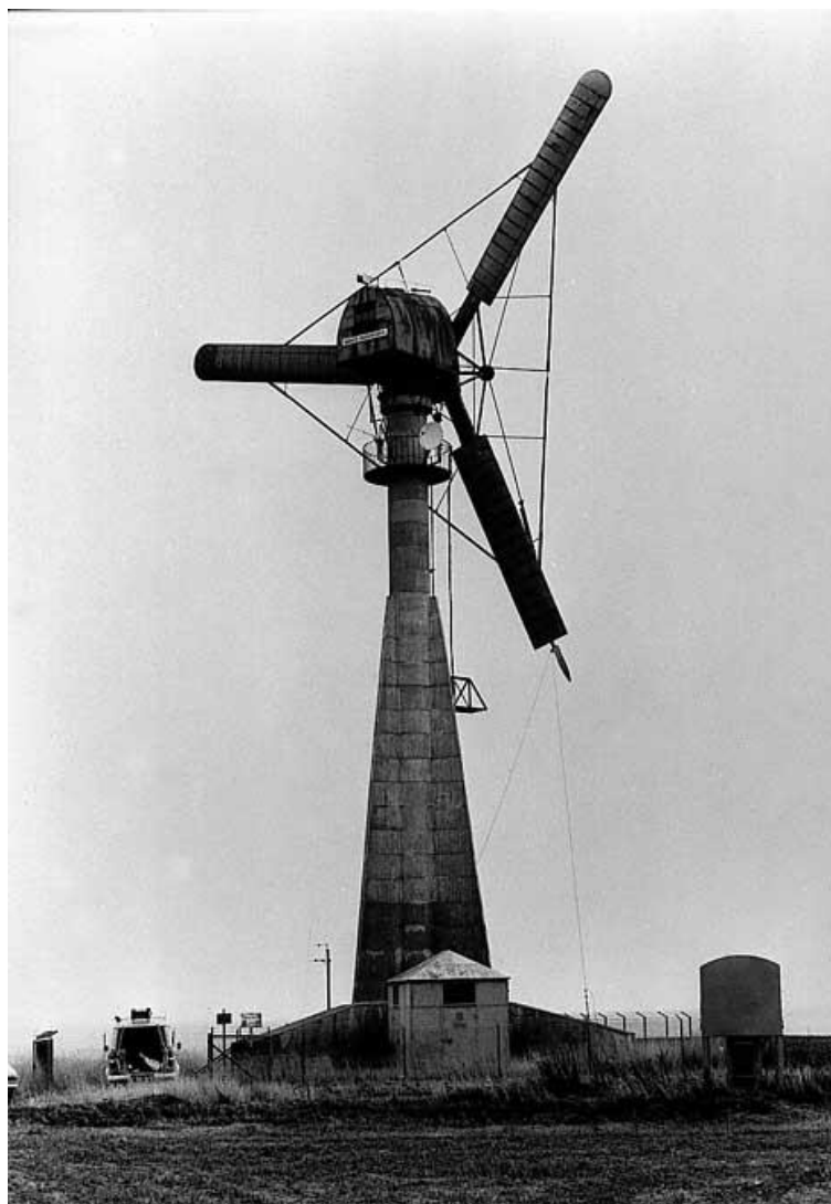
Figura 7 – Aero gerador da Ilha de Gedser, com uma geração de 200 kW (Fonte: www.windpower.dk ).
