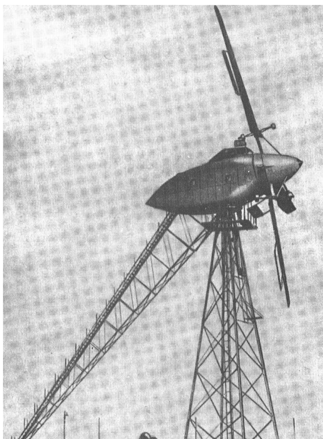
Figura 5 – Turbina Balaclava com uma potência de 100 kW em 1931 (Fonte: Dutra, 2001).
