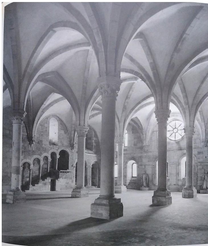
FIGURA 4: FOTOGRAFIA DO REFEITÓRIO DA ABADIA DE SANTA MARIA DE ALCobaça
