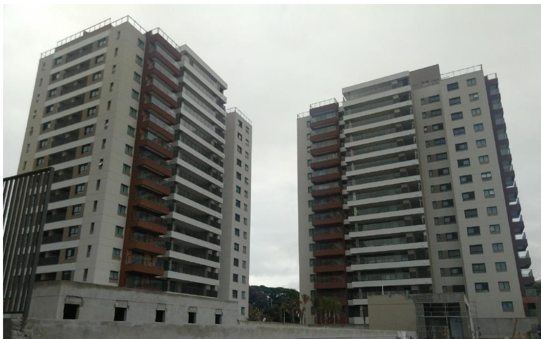
Figura 4 – Fachada das Torres A e B (em construção)
