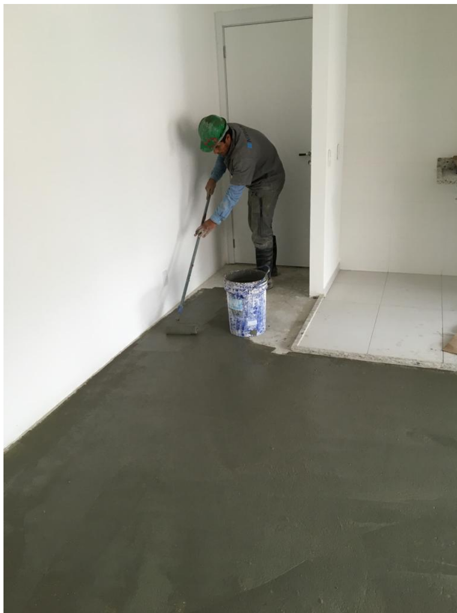
Figura 29 – Processo de recuperação das fissuras superficiais
