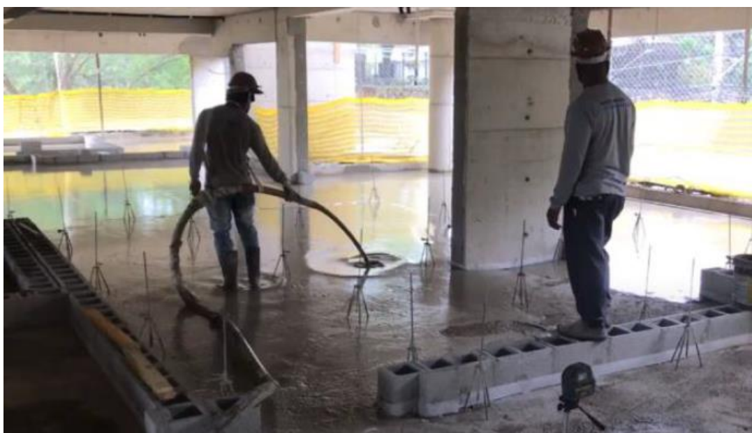
Figura 21 – Aplicação da Argamassa Fluida
