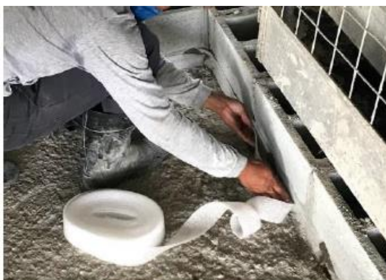
Figura 19 – Execução de junta de dessolidarização
