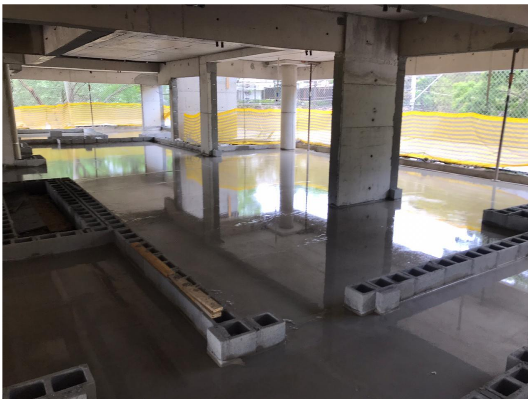
Figura 20 – Contrapiso em argamassa fluida executado na Torre C
