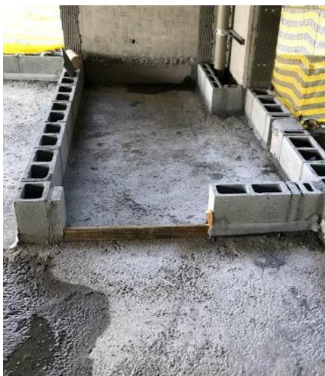
Figura 18 – Contenção executada no primeiro pavimento da Torre C
