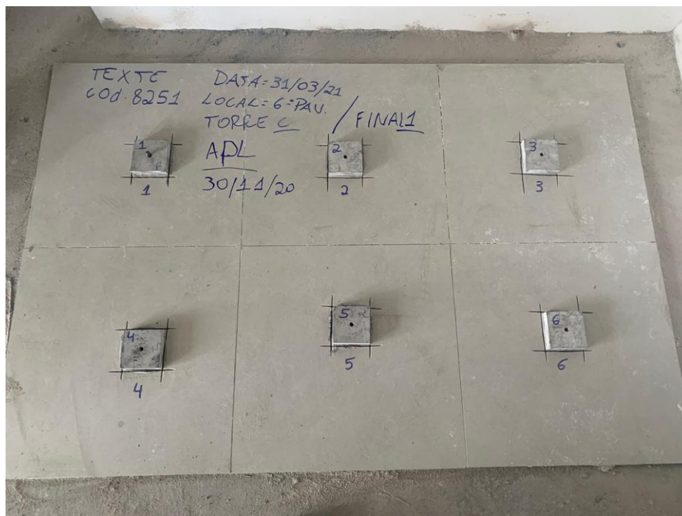
Figura 23 – Ensaio de resistência de aderência à tração
