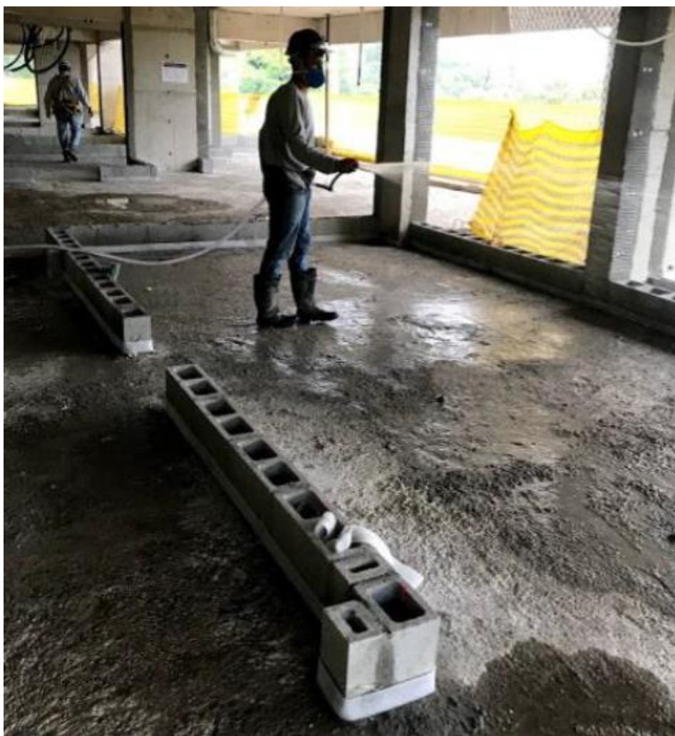
Figura 16 – Preparo da estrutura
