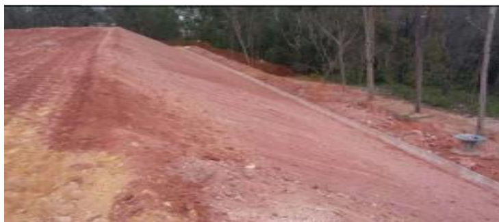
Figura 23 – Adição de camada de solo sobre a geomembrana de PEAD
