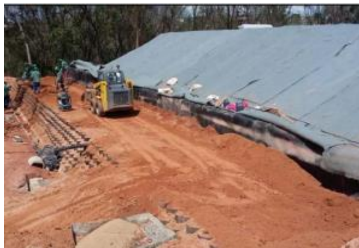
Figura 22 – Aterro fechado e impermeabilizado com geomembrana de PEAD.
