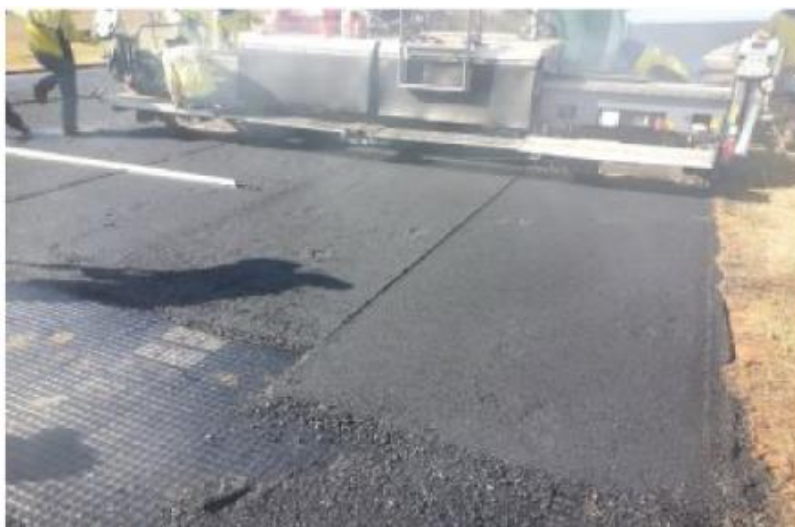
Figura 28 – Aplicação da camada de SMA (Stone Matrix Asphalt) no Autódromo Ayrton Senna.
