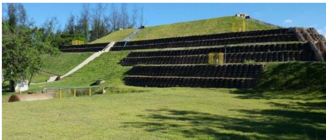
Figura 24 – Reintegração da área do aterro ao meio ambiente após finalização da obra.
