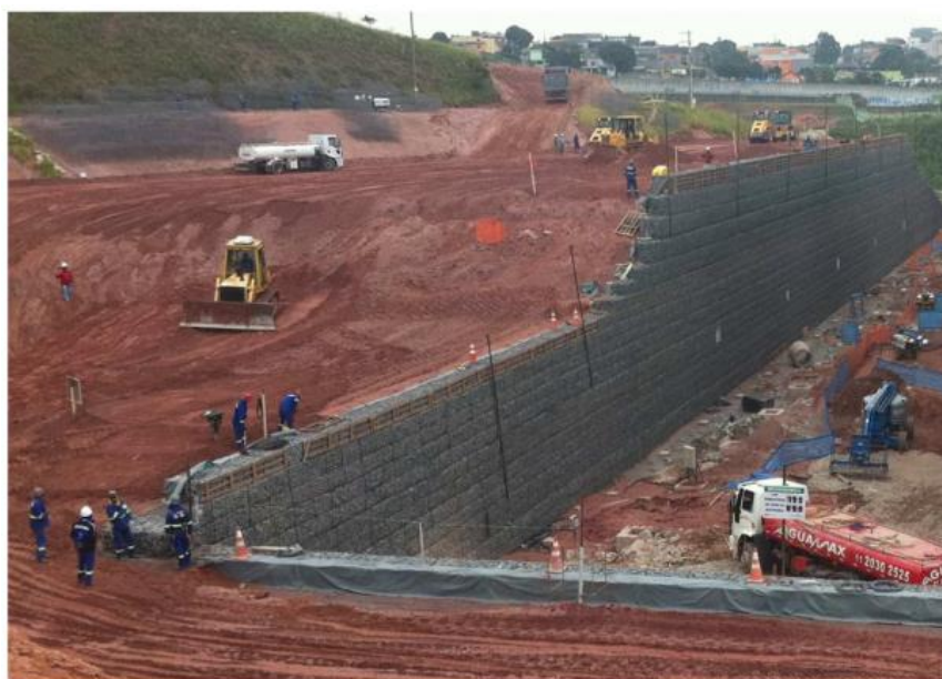
Figura 17 – Detalhe da inserção das geogrelhas entre os elementos de face do solo reforçado de contenção.
