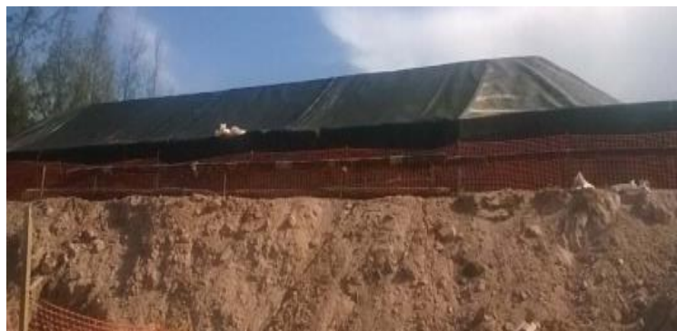
Figura 21 - Aterro após instalação da geomembrana de PEAD
