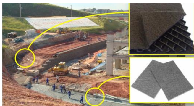
Figura 16 – Utilização dos geocomposto drenantes e geotêxteis na contenção em solo reforçado.
