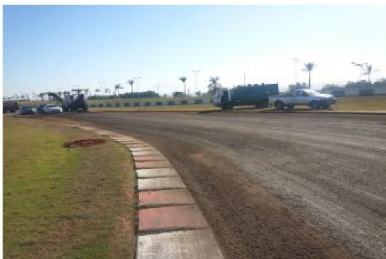
Figura 25 – Pavimento do Autódromo Ayrton Senna antes da obra.
