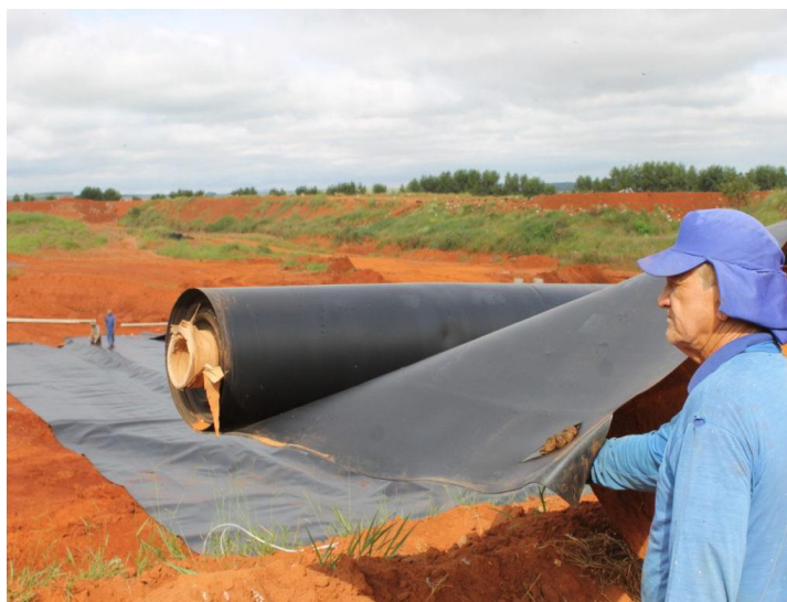
Figura 4 – Geomembrana aplicada na impermeabilização do solo.
