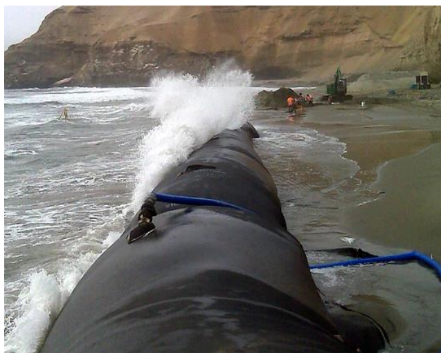
Figura 6 – Geobags utilizadas como barreira de contenção para proteção costeira.
