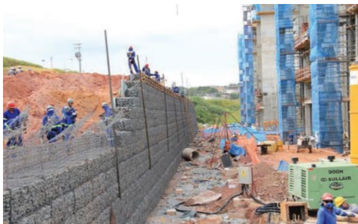
Figura 13 - Estrutura de contenção de talude da Arena Corinthians, utilizando o sistema Terramesh.
