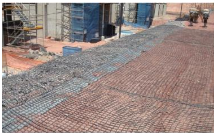
Figura 14 – Geogrelha instalada entre os elementos de face da estrutura em solo reforçado da Arena Corinthians, São Paulo (SP).
