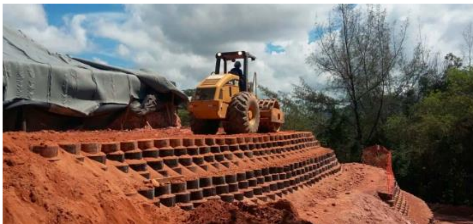
Figura 19 - Geocélulas preenchidas com solo
