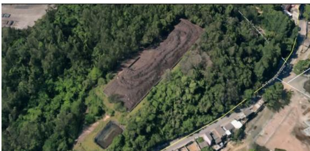
Figura 18 – Vista do aterro de Cariacica (ES), antes de seu fechamento em 19 de janeiro de 2017.
