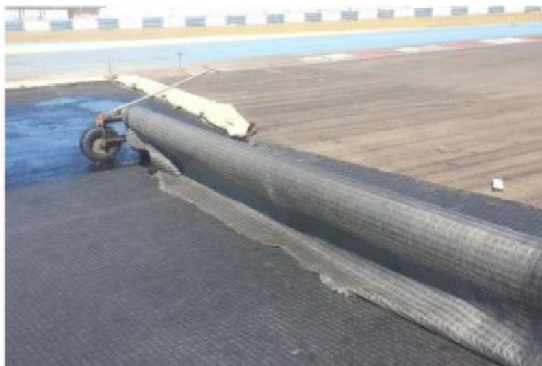
Figura 27 – Aplicação do MacGrid® AR como reforço asfáltico no Autódromo Ayrton Senna.
