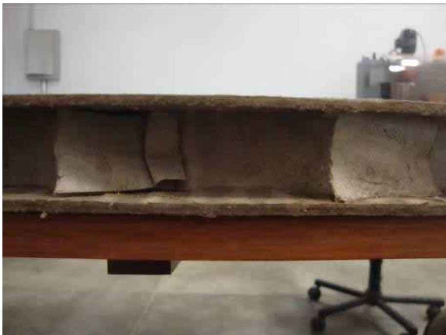
Figura 16: Divisória HDF – Estrutura interna
