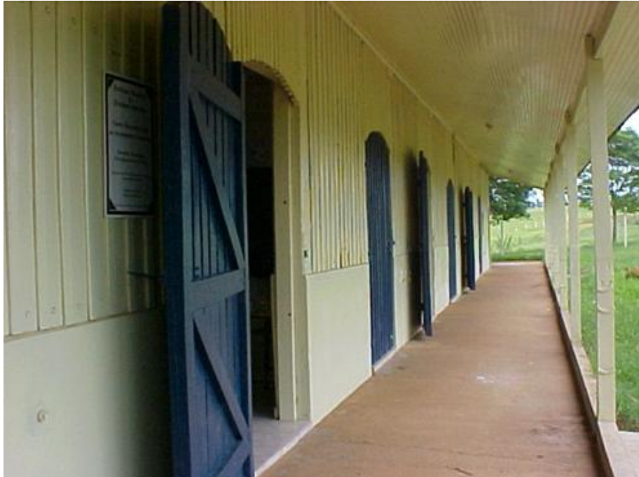
Foto 12: Corredor (externo) do prédio de salas de aula da Escola do Assentamento Primavera
