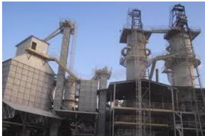
Figura 3 - Forno Vertical de Fluxo Paralelo Regenerativo
