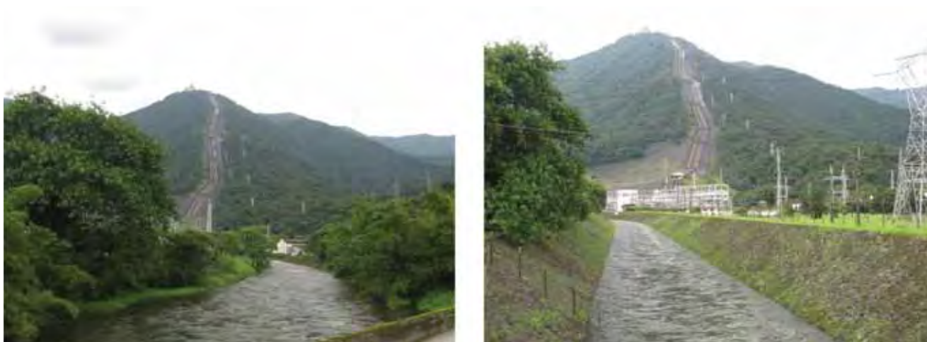
Figuras 42 e 43 – Canais fluviais canalizados que drenam trecho da unidade Rampas Colúviais Urbanizadas.
