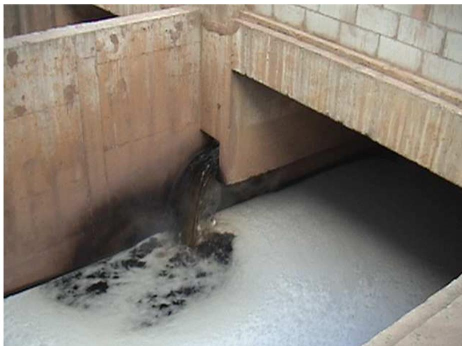
**Figura 3.8:** Sistema de coleta de chorume. Aterro Bandeirantes
