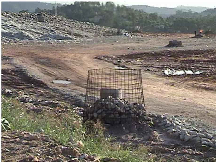
**Figura 3.7** – Sistema de captação de metano. Aterro Bandeirantes.
