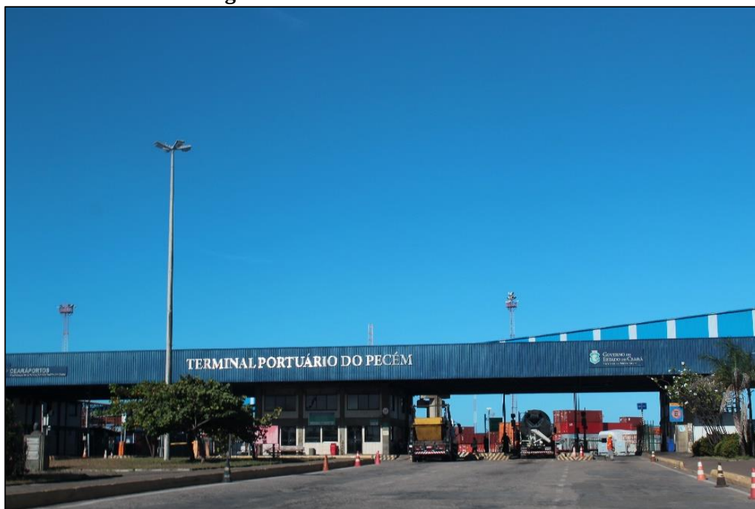
Figura 6: Entrada do Terminal do Pecém
