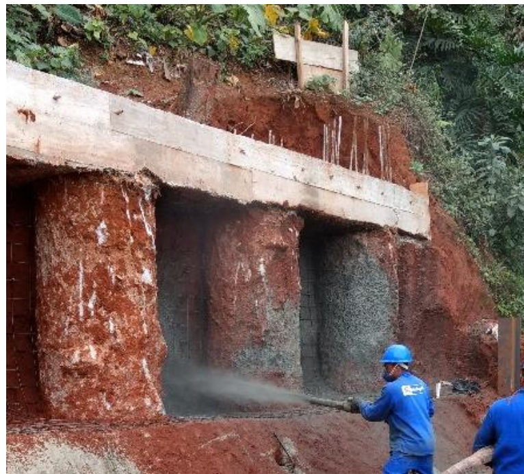
Figura 23 – Tubulões finalizados
