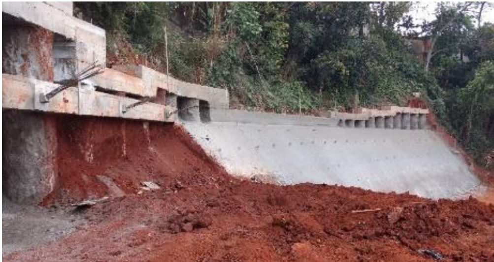
Figura 31 – Visão geral da contenção do talude sendo executada
