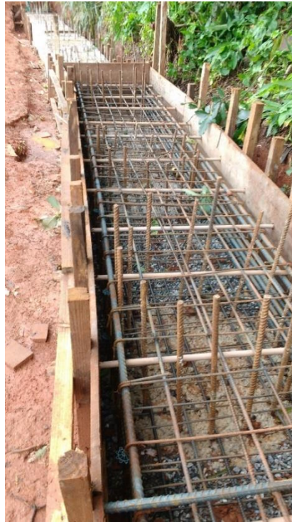
Figura 22 – Execução da viga de coroamento dos tubulões
