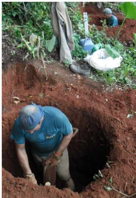
Figura 19 – Escavação manual dos tubulões
