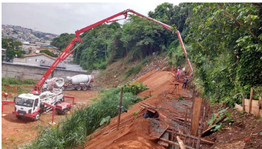
Figura 20 – Concretagem dos tubulões
