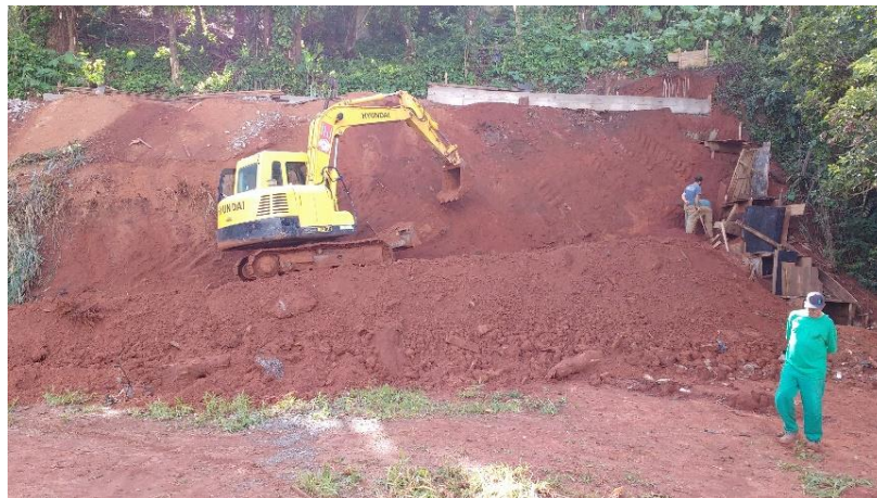
Figura 28 – Escavação para implantação de solo grampeado
