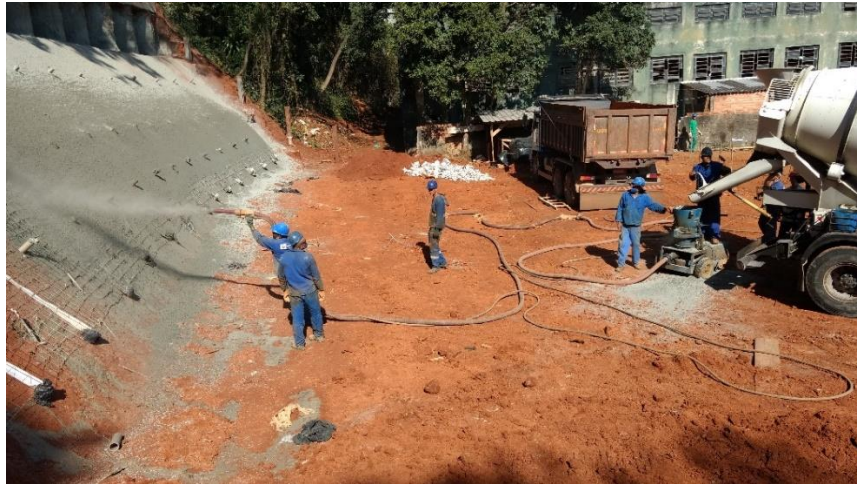
Figura 29 – Execução do concreto projetado em solo grampeado
