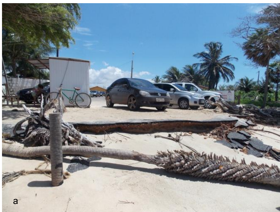
Figura 5.19 – a: destruição de estrutura urbana que bordeja a praia de Macapá por ação de agentes oceanográficos. b: destruição de vegetação frontal localizada na pós-praia
