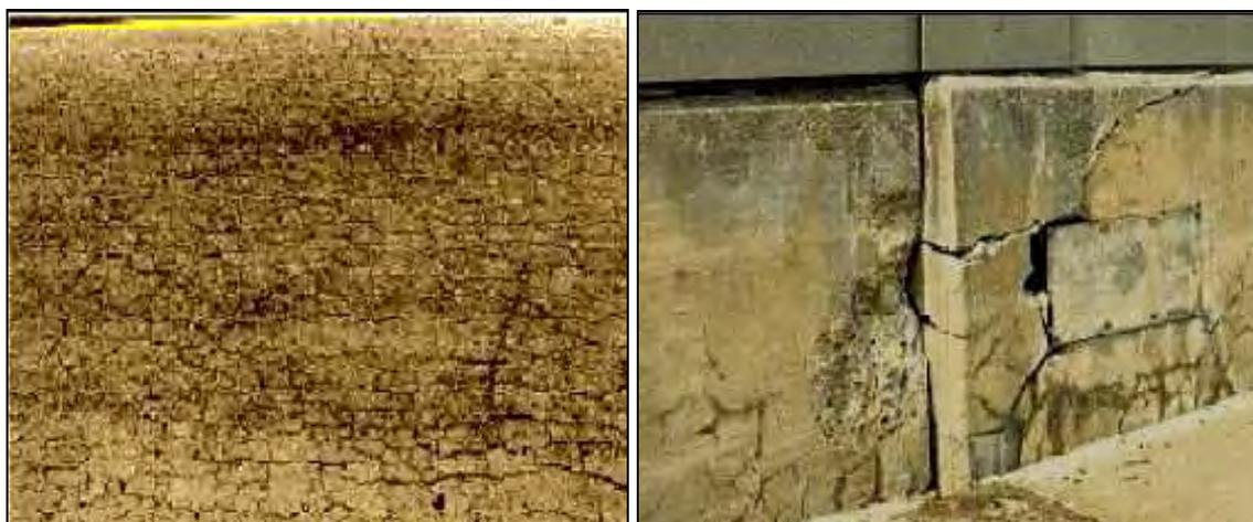
**Figura 1.2:** Fissuras em rodovias e deslocamento diferencial numa ponte.
