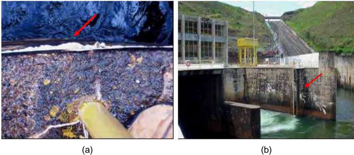
**Figura 3.2:** UHE Jaguari - SP. a) Material branco na superfície do concreto, b) Local de coleta do material – saída da Tomada D`Água.
