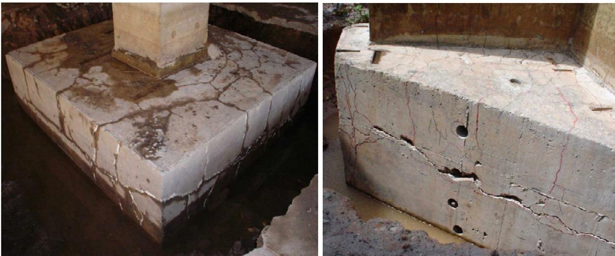
**Figura 1.3:** Fissuração em blocos de fundação afetados pela RAA.
