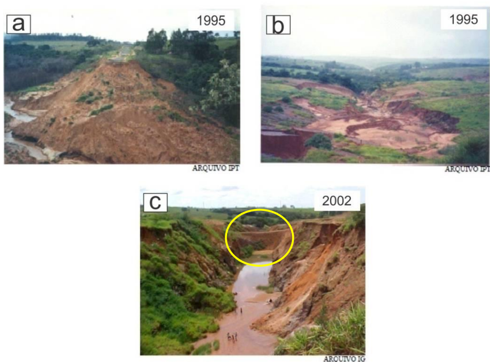
Figura 4: Evidências de riscos geológicos eminentes por ação descontrolada de processos erosivos. a) Rompimento de um trecho da vicinal que liga São Pedro/Charqueada; b) A erosão progrediu de maneira muito intensa, até as adjacências das moradias próximas à cabeceira; c) Dique de terra, destacado pelo círculo amarelo, construído pela Prefeitura a fim de ligar os bairros. Fonte: ALMEIDA FILHO et al. (2004).
