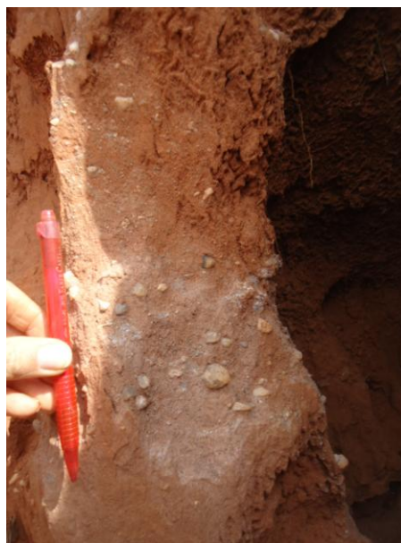
Figura 6: Detalhe da linha de pedras localizada no contato solo/rocha.
