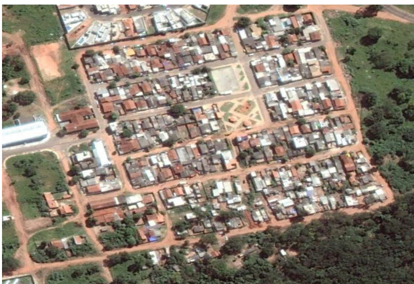
Figura 37: Jardim Niceia após intervenções urbanísticas (2016)
