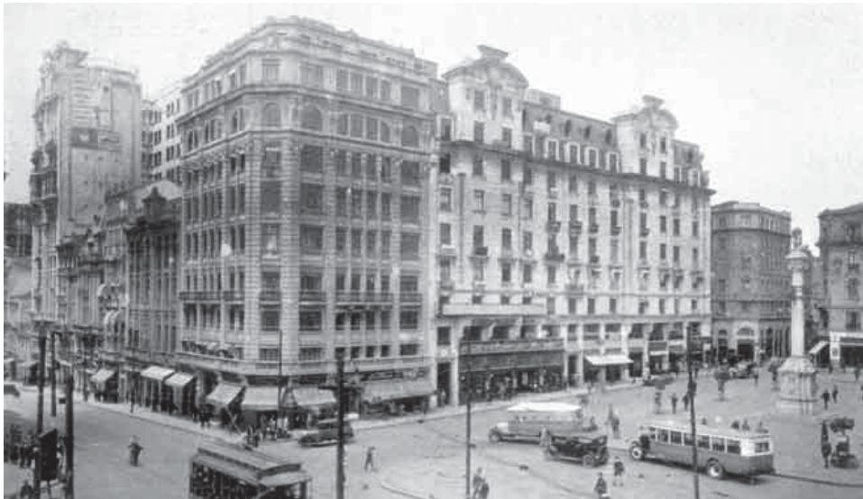
Figura 4: Praça do Patriarca, entre as décadas de 1920 e 1930. Fonte: Google images.
