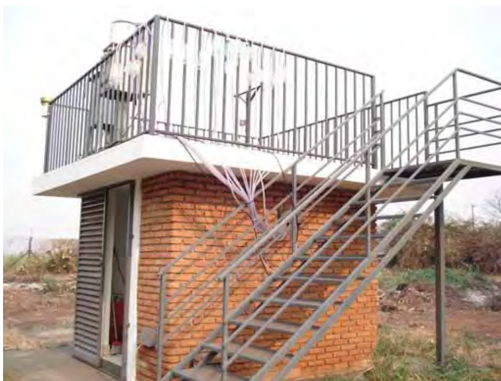
Figura 5- Foto das instalações de amostragem em Araraquara
