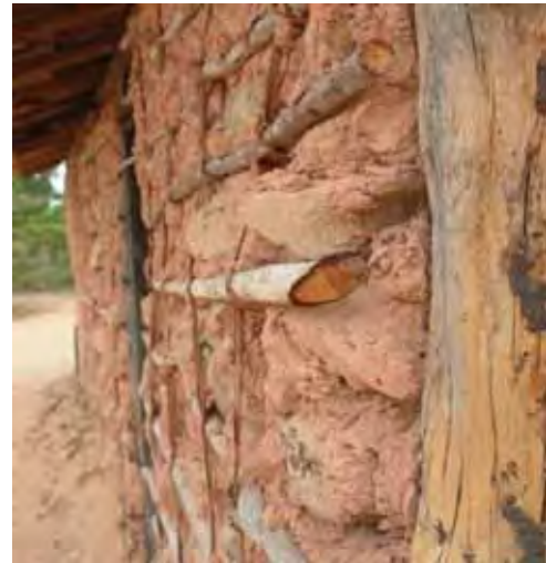
Figura 35 – Parede de Taipa, construção em terra do local, utilizando espécies arbóreas do Cerrado - Carolina-MA. Fonte – MARQUES, 2009.
