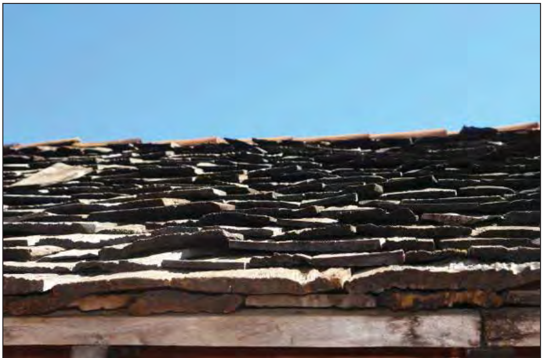
Figura 37 – Detalhe do telhado de cavaco de madeira de Bacuri; é construída em sistema intercalado, um sobreposto ao outro, que impede a passagem de água da chuva, com alta durabilidade (em torno de 25 anos, segundo informações obtidas no local junto ao morador). Fonte – MARQUES, 2010.
