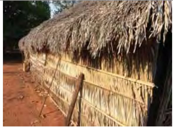
Figura 33- Parede de Moradia Tradicional construída em fibra de palmeiras - Carolina-MA. Fonte – MARQUES, 2009.
