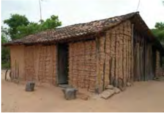
Figura 34 – Moradia Tradicional construída em taipa; cobertura de telha de barro; utilização de madeiras de espécies do cerrado – Carolina-MA. Fonte- MARQUES, 2009.
