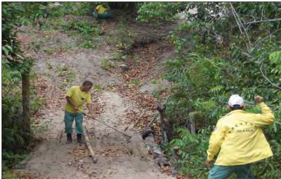
Figura 47- Brigadistas em atuação na reforma das estradas no PNCM. Além de desempenharem o papel de prevenção e combate aos incêndios no interior e zona de amortecimento da unidade, eles precisam arrumar as estradas que estão em péssimo estado, pois é imprescindível para que consigam fazer o deslocamento necessário para alcançar os pontos de incêndios detectados pelo monitoramento via satélite.
