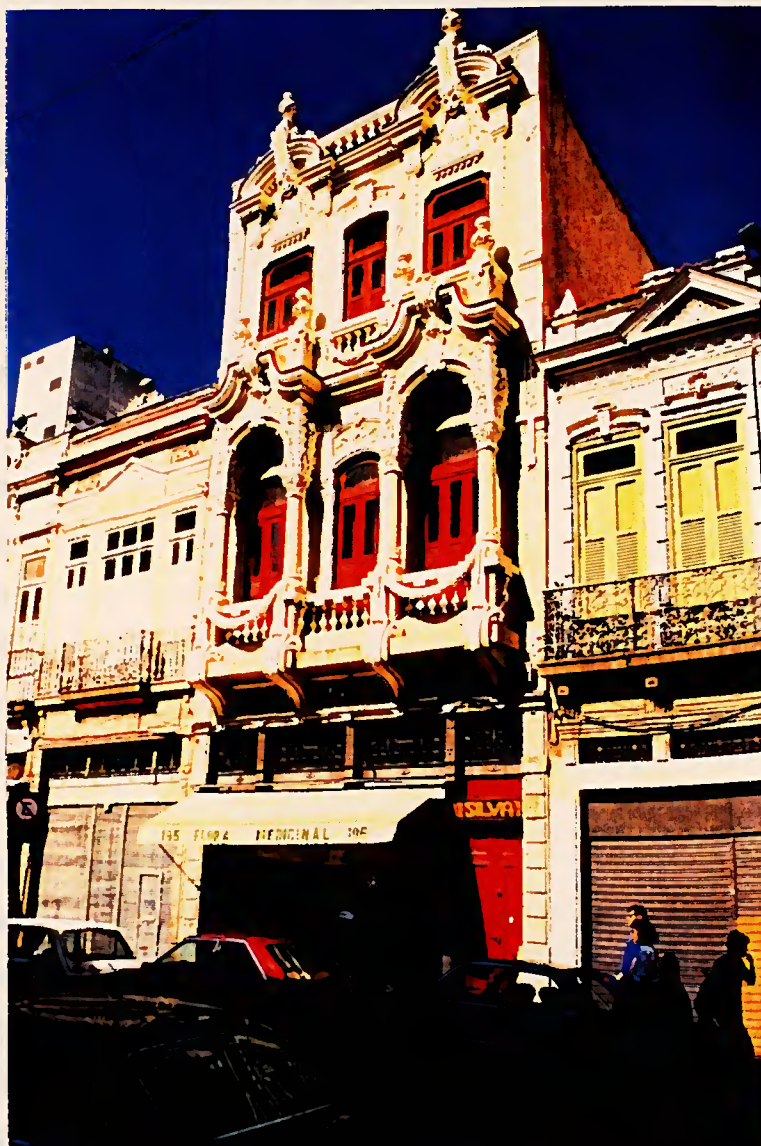
Figura 146 - FACHADA ECLÉTICA - Rua Sete de Setembro , Rio de Janeiro , autoria desconhecida , construída no ano de 1905 .
