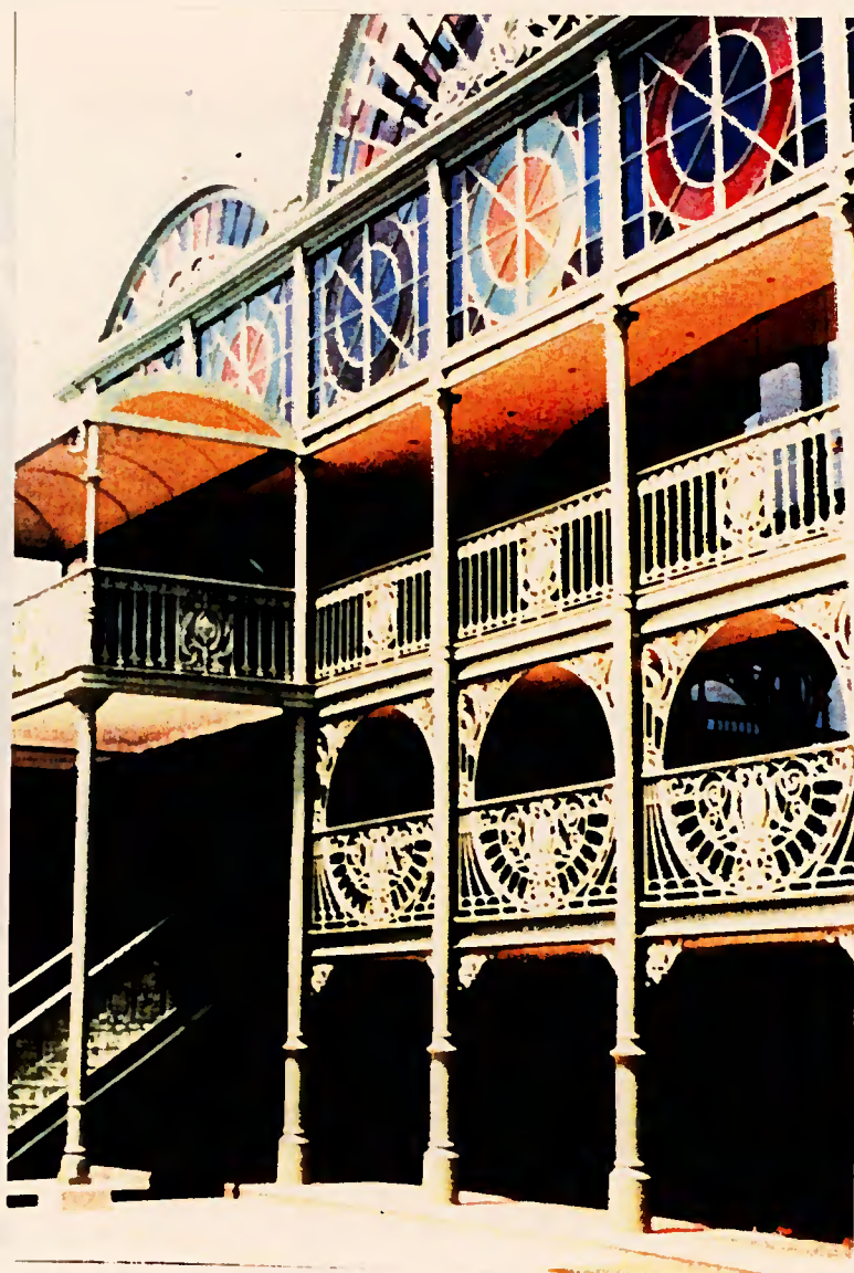
Figura 161 - FACHADA DO CORPO INTERNO DO TEATRO JOSÉ DE ALENCAR - Walter MacFarlane & Co. , Aço e vidro , s.m. , 1908 - 1910 , Fortaleza , Ceará .
