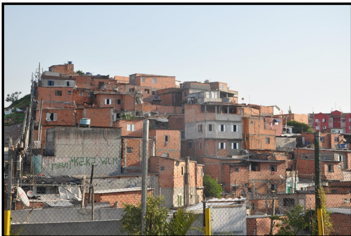
Foto 5- Vista traseira do SC Interlagos. Fonte: MadeiraFilho, 2015.
