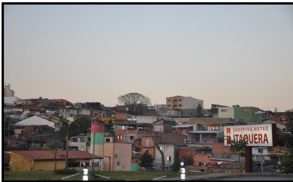
Foto 3-Autoconstrução ao redor do SC Metrô Itaquera. Fonte: Madeira Filho, 2015.
