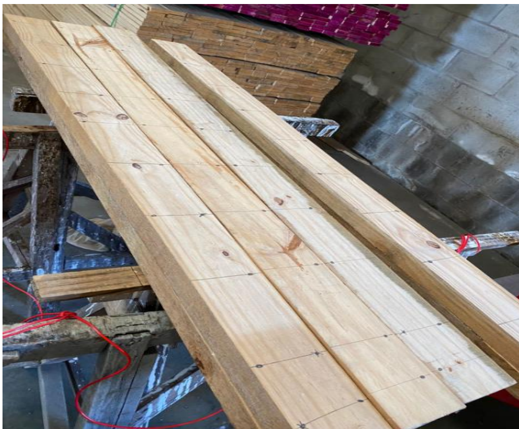
Figura 34 – Marcação dos pontos para receber os pregos.
