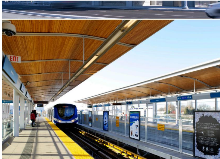
Figura 6– Laje de MLP ondulada da Aberdeen Station .
