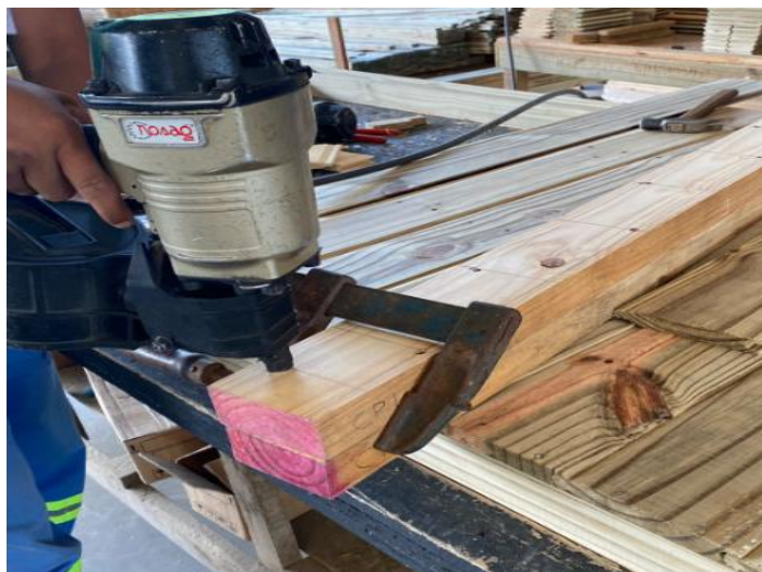
Figura 35 – Fixação das vigas de MLP.
