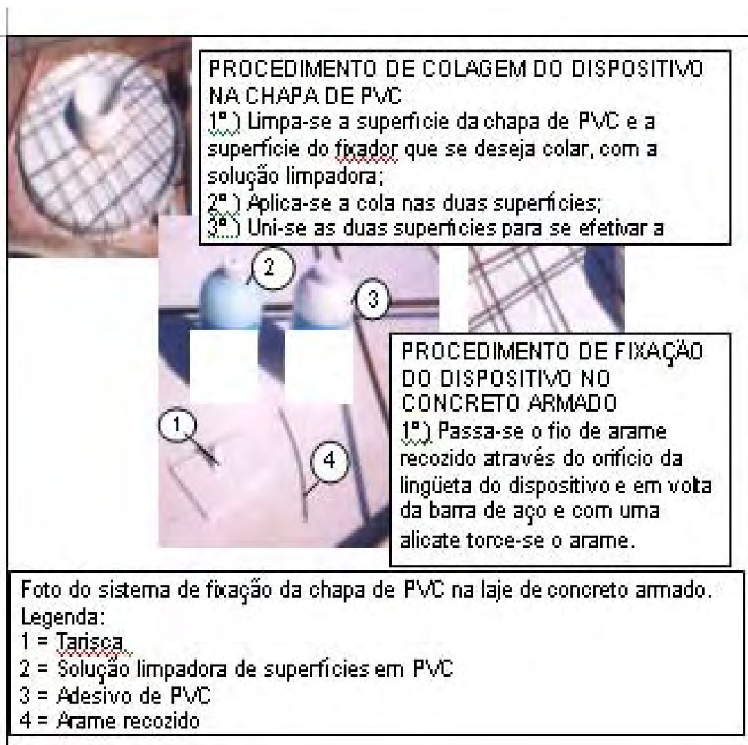
Figura 1.5 - Fotos e descrição do procedimento de fixação do artefato na chapa de PVC e sua fixação nas ferragens da laje.
