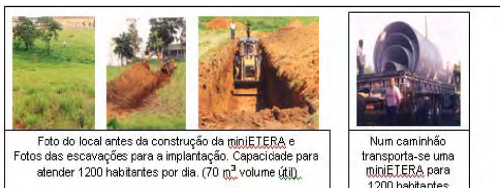
Figura I.1 - Sequência de fotos da preparação do terreno e chegada dos tubos.
