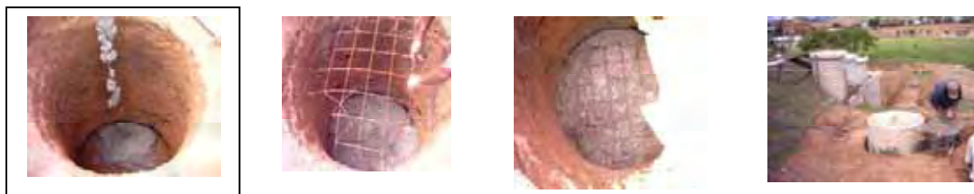
Figura 5.7 – Concretagem e junção do concreto armado ao tubo de PVC
