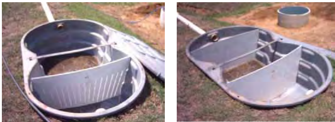
Figura 4.9 – Colocação das grades em PVC na caixa d' água de 1.000 ℓ
