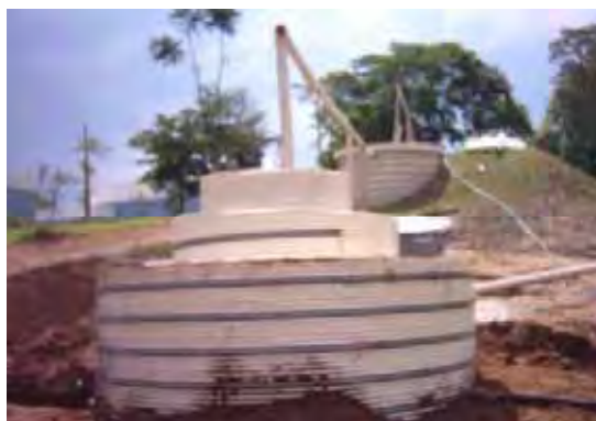
Figura I.10 - Acomodação dos tubos de PVC de 2.500, 2.000, 1.500 e 1.200mm de diâmetro.
