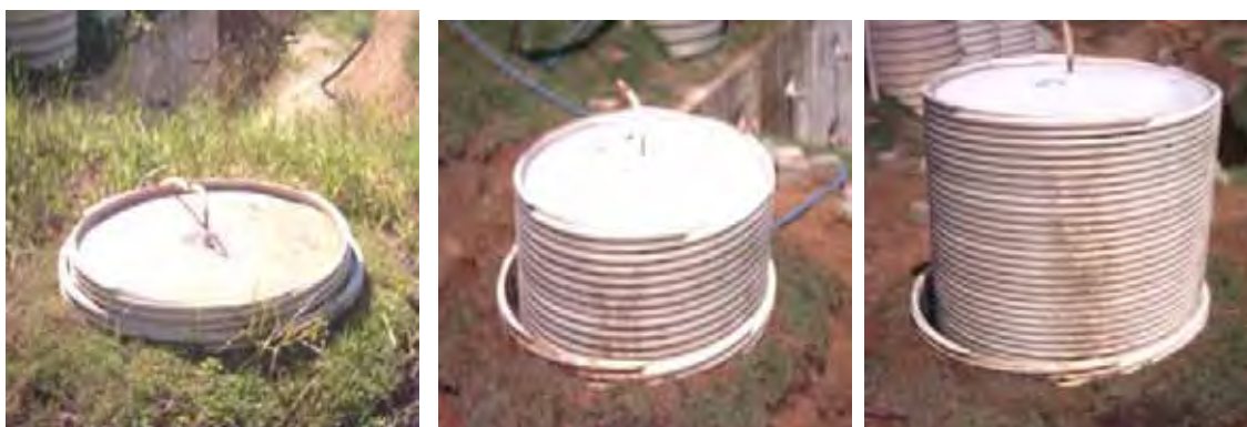
Figura 5.3 – (A) Gasômetro vazio; (B) Gasômetro com meia carga; (C) Gasômetro com plena carga.
