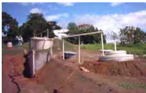
Figura I.11 - Reaterro do SOBAA.
