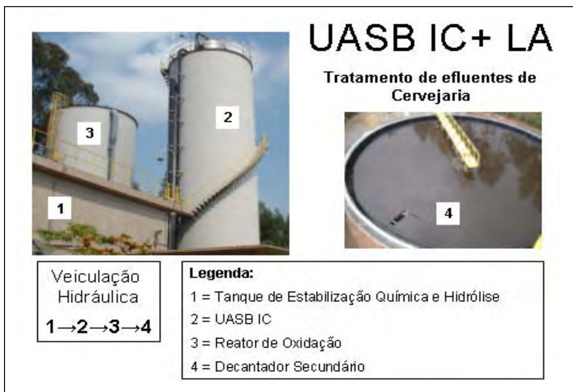
Figura 2.5 – Ilustração de sistema UASB IC + LA para tratamento de efluente da indústria cervejeira (Fotografado e montado pelo autor, Cervejaria Kaiser, Unidade Jacareí SP).
