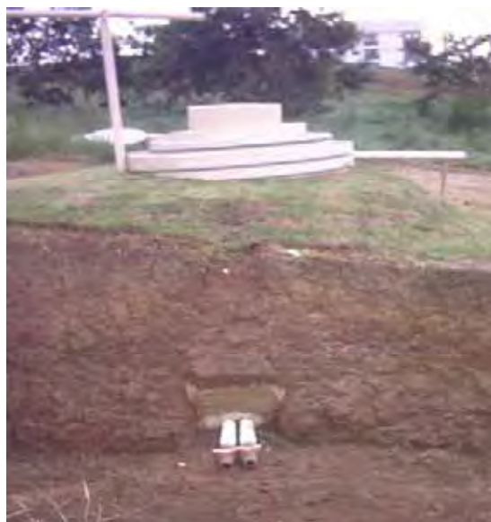
Figura I.13 - Colocação das válvulas para retirada dos lodos aeróbio e anóxico.
