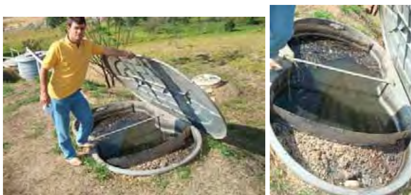
Figura 4.10 – Vista do sistema retendo gorduras e sólidos grosseiros.
