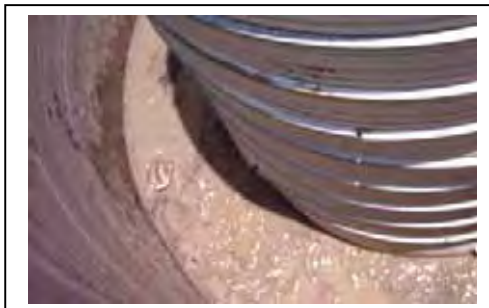
Figura I.9 - Ancoragem do tubo de PVC de 1.500 mm de diâmetro no concreto armado.
