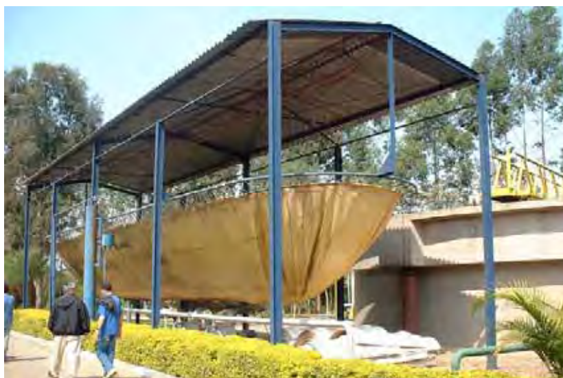
Figura 2.8 – Gasômetro do tipo Zeppelin fora de operação por motivos de segurança.
