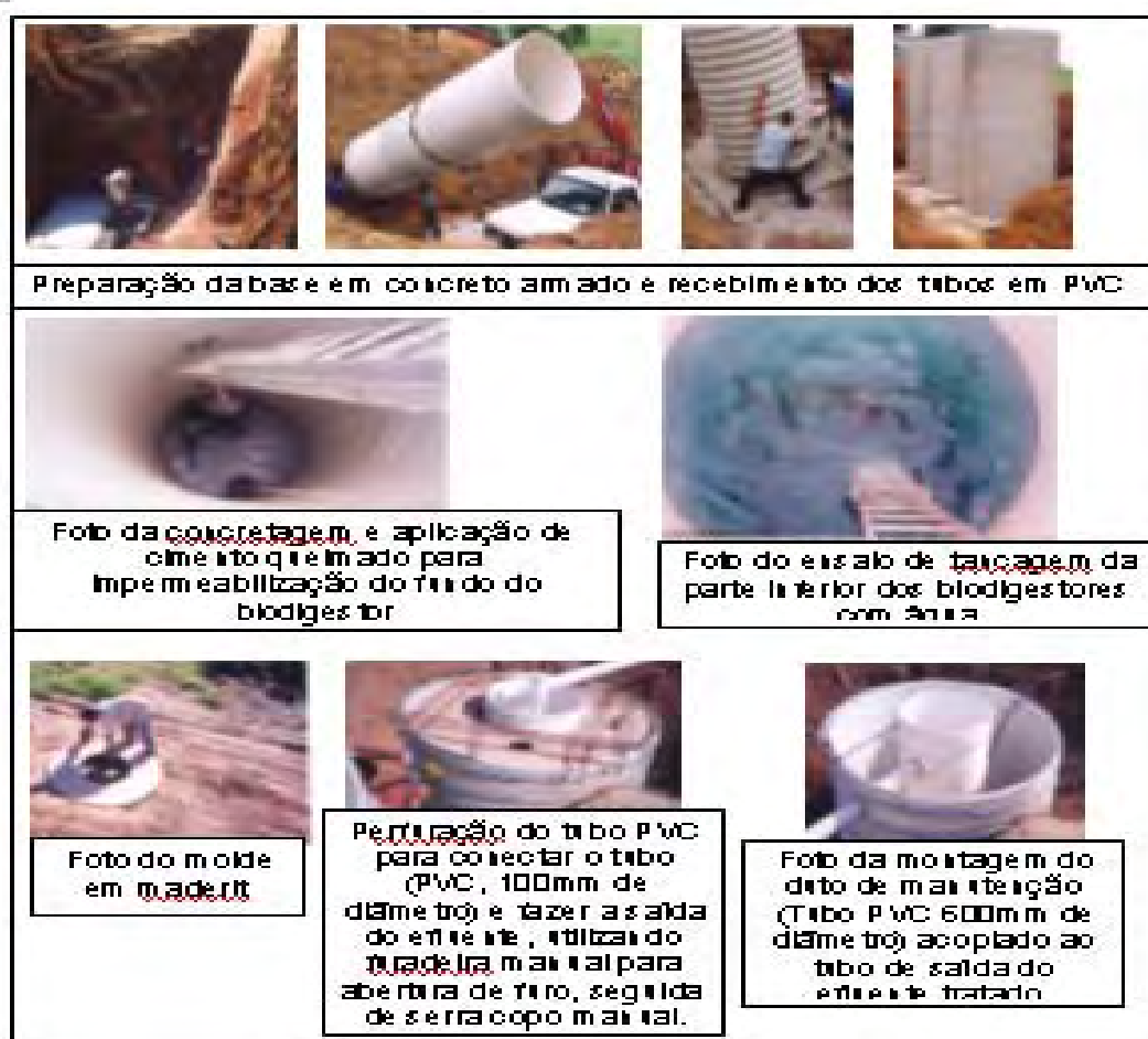
Figura I.2- Sequência de fotos da acomodação dos tubos, da vedação do fundo dos biodigestores, do ensaio de tancagem e da preparação da campânula.
