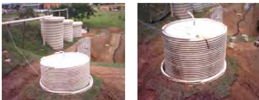
Figura 5.12 – Gasômetro acabado e conectado ao sistema biodigestor anaeróbio para a coleta e o armazenamento do biogás
