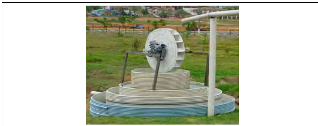
Figura 4.13 – Foto do sistema biodigestor aeróbio-anóxico implantado.
