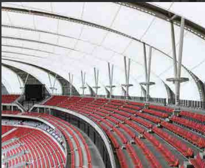
Figura 13 - detalhe pilar - Estádio Soccer City - África do Sul
