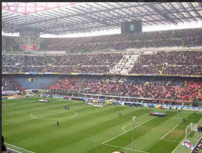
Figura 11 Estádio San Siro, Milão, Itália
