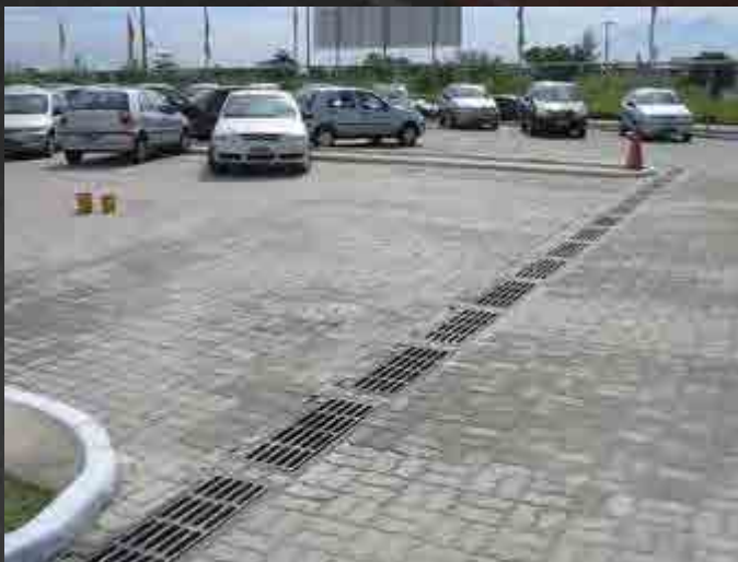
Figura 19 - Estacionamento com bloco intertravado Fonte: http://www.alzengenharia.com.br/localizarentacar.html
