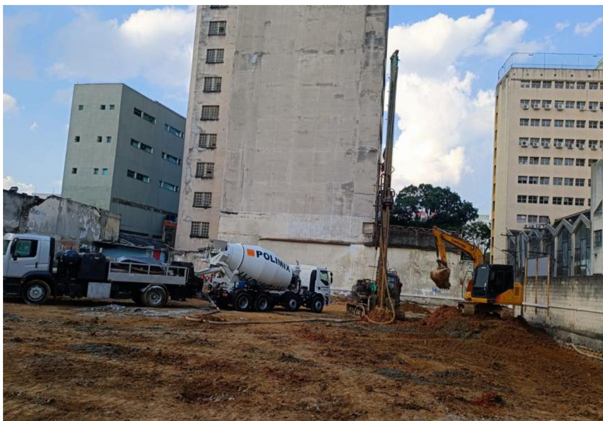
Foto C.6. Execução da estaca hélice.
