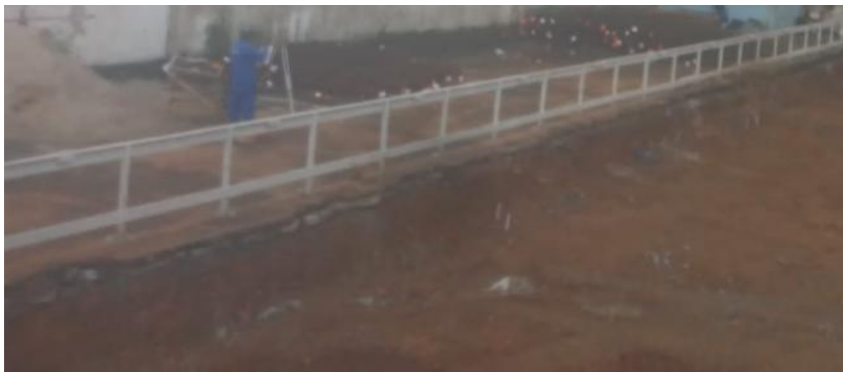
Foto C.5. Montagem do gabarito.
