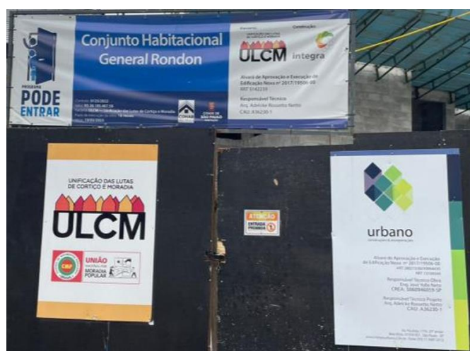
Foto C.2. Identificação da obra.
