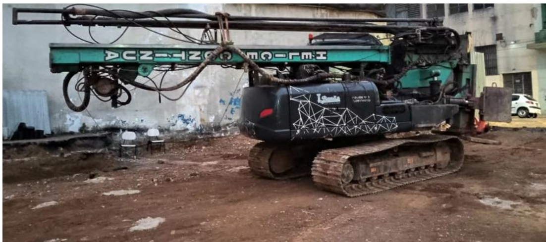
Foto C.4. Perfuratriz da estaca hélice contínua.
